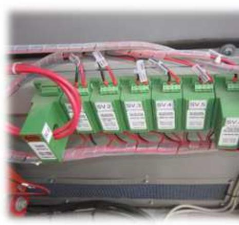
Fotografía 1 y 2: Sensores de Corriente y Voltaje
