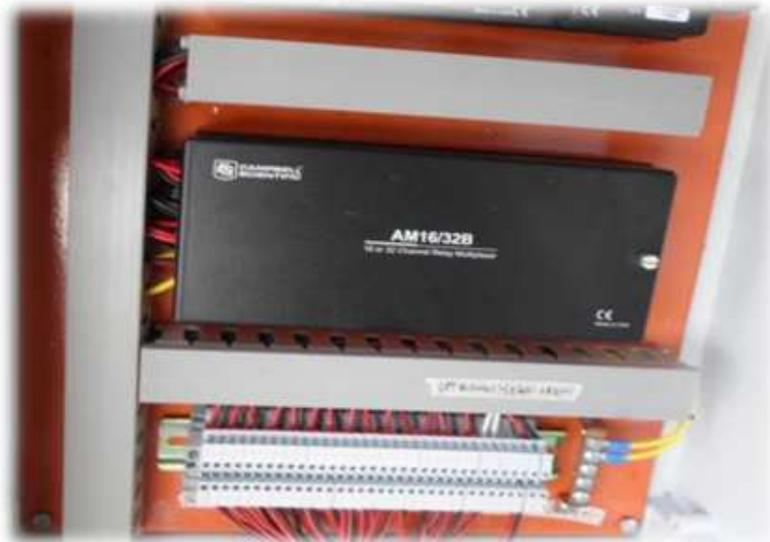
Fotografía 3.- Multiplexor y distribución de Señales analógicas.
