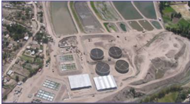
Figura 1. Vista de la Planta de Tratamiento de Aguas Residuales PTAR “La Totora” – Ayacucho. (2)
