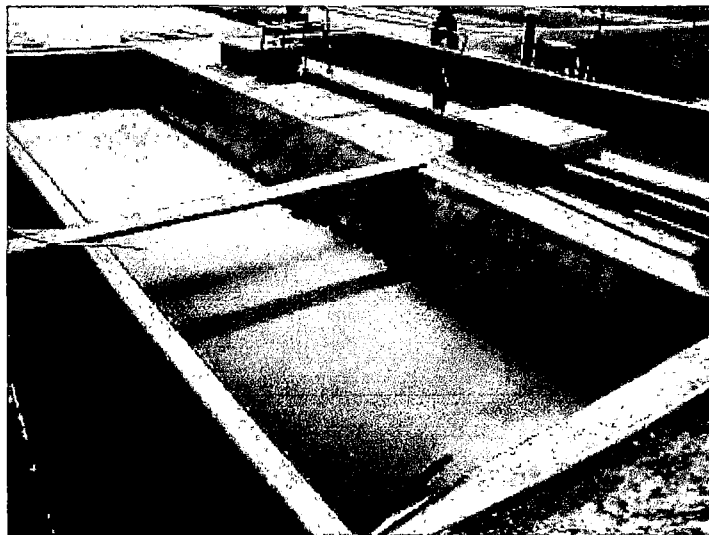
Foto N°12. Fuente de agua residual utilizado para la alimentación de los humedales artificiales (efluente de UASB-CITAR)
