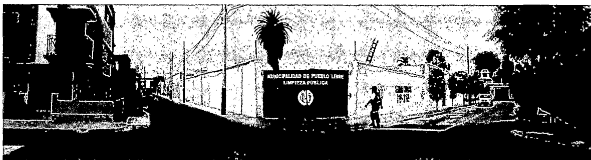
Figura 23. Estado del terreno, esquina.
