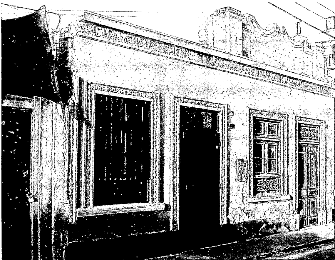
Figura 19. Edificación de valor monumental, calle Barreda, cdra. 3.
