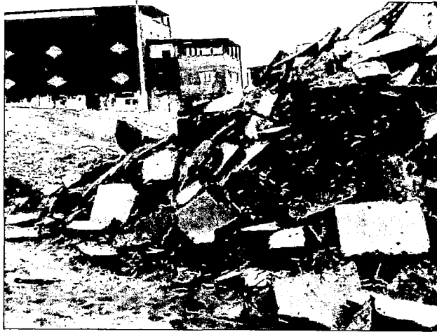
Foto N° 116 Desmonte arrojado a las áreas de recreación. Era parte de una losa deportiva. Parque Las Orquídeas. Asentamiento Humano Fortaleza II. Zona 5, Pampas de San Juan. Archivo Propio
