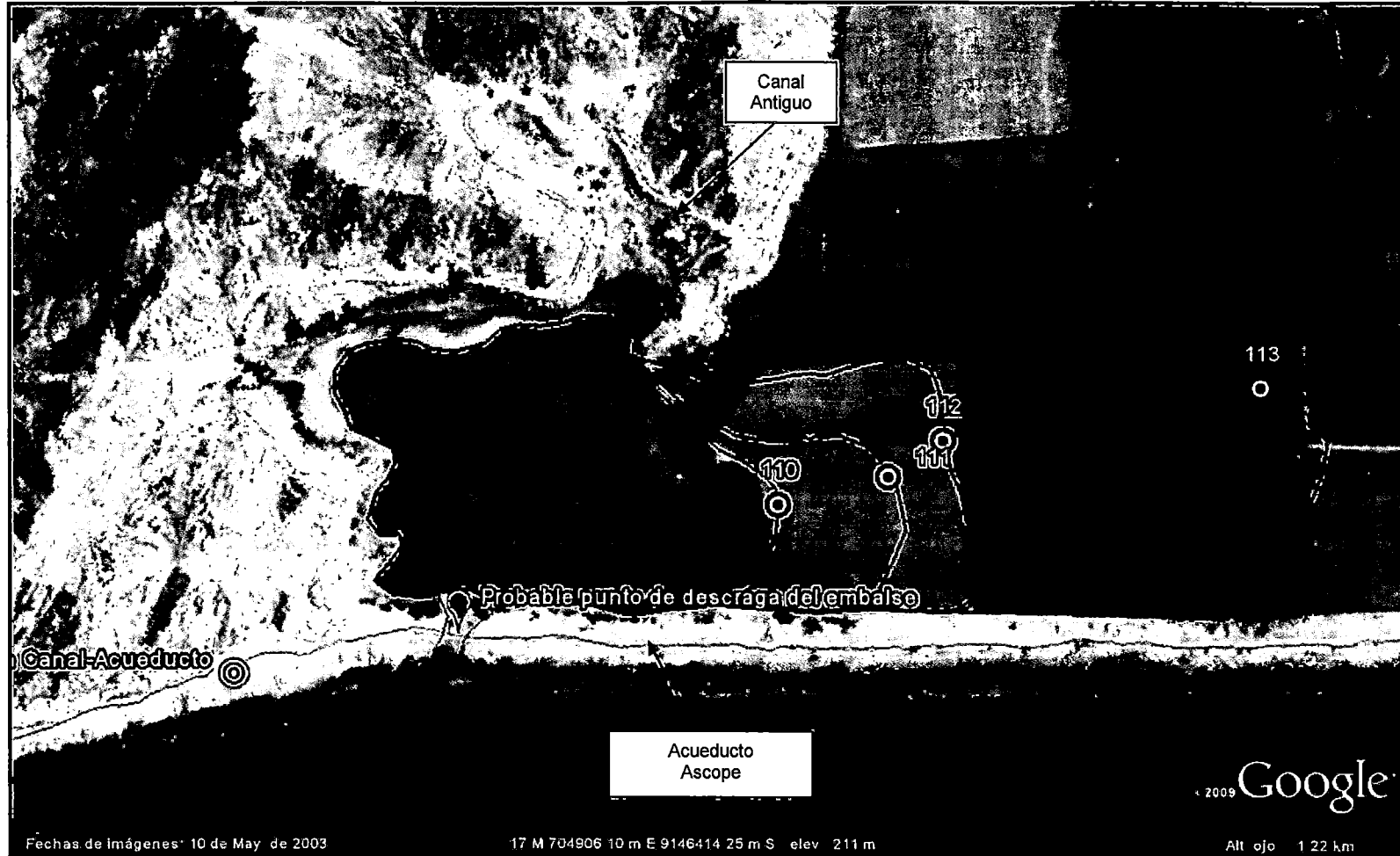
Foto 4.14 - Probable Ubicación de la Descarga del Embalse San Bartolo
