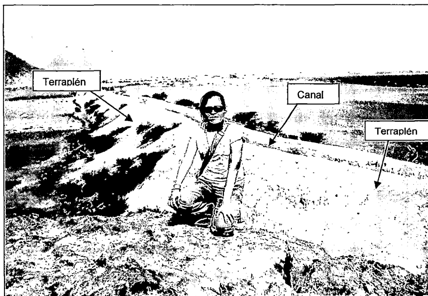
Foto 3.8 – Vista panorámica Acueducto de Ascope
