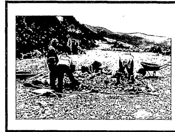
Imagen N° 14: Vista panorámica del análisis granulométrico global en campo del material extraído de la calicata C-1.
