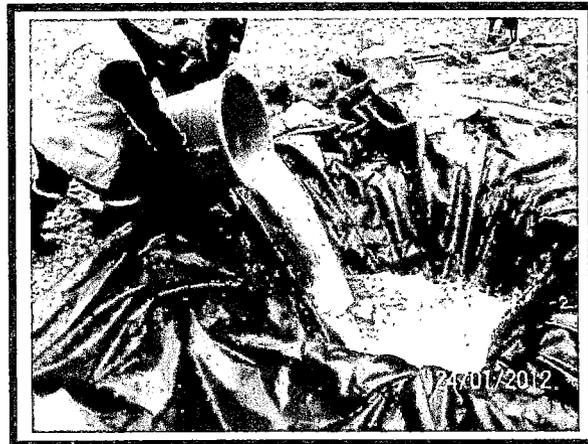
Imagen N° 9: Vista del reemplazo de agua durante la realización de ensayo de densidad de campo por reemplazo de volumen de agua en la calicata C-1.
