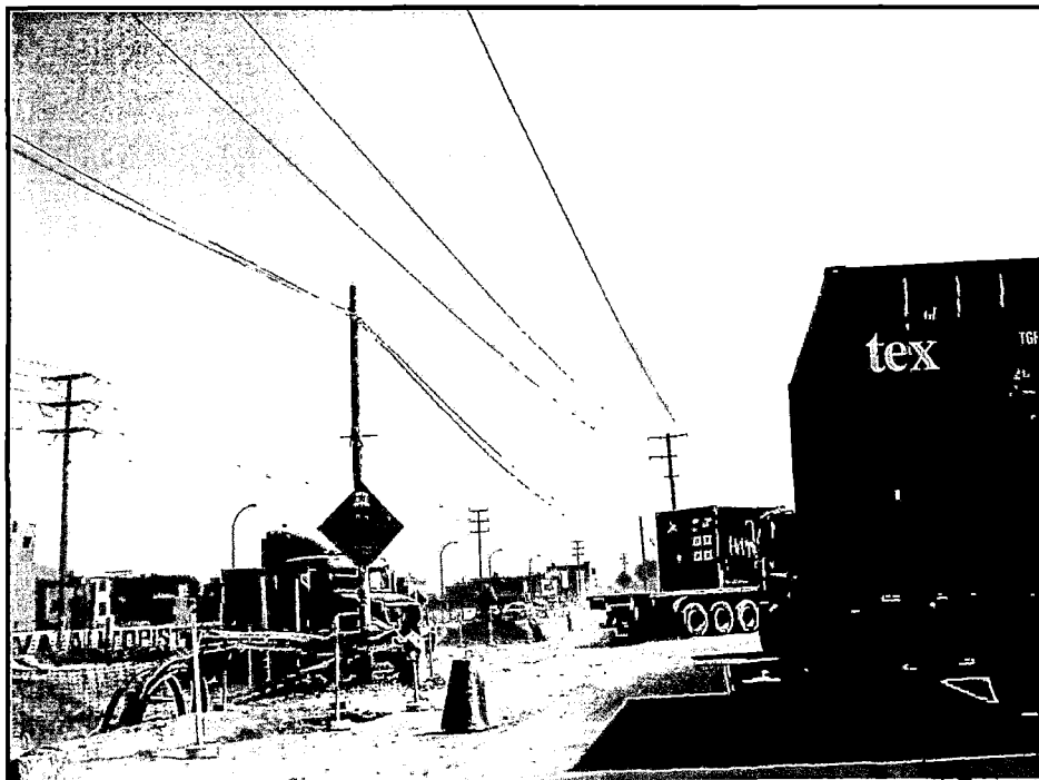
Foto N° 8.2 Av. Néstor Gambeta falta de señalización y acceso de transporte de Carga formando tráfico y provocando una accidente de tránsito.
