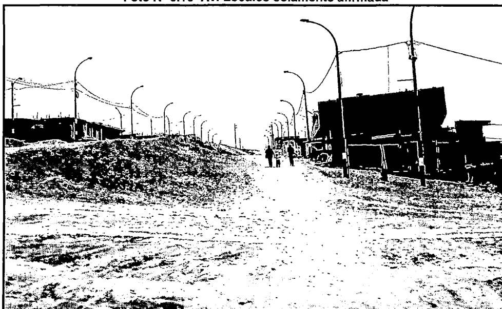
Foto N° 6.10 Av. Locales solamente afirmada
