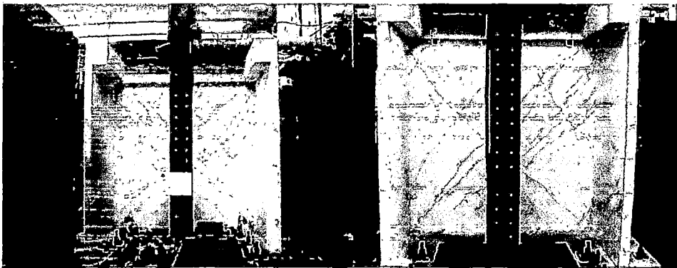
Figura 3.30. Distorsión 1/200: Vista sur y norte de las grietas en alma.
