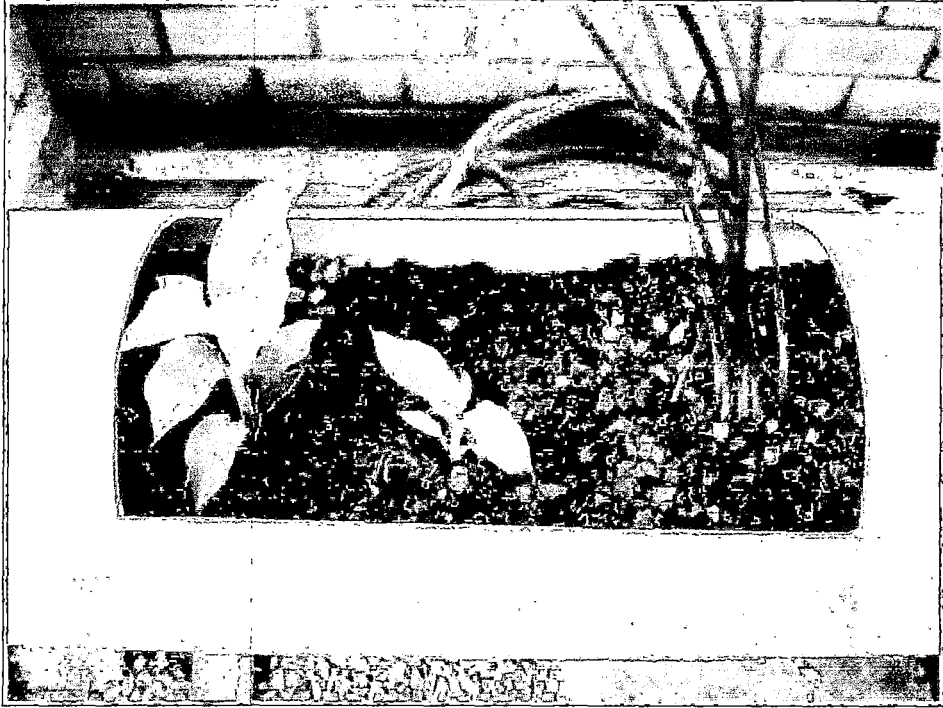
Foto N° 45: Planta (totora) y difusor instalados en el lecho de piedra del Wetland.
