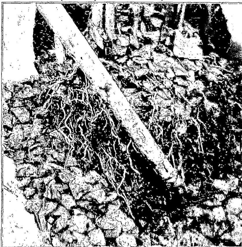
Foto N° 57: Tubería de distribución del aire que llega hasta la base de la totora, por debajo del lecho de soporte.
