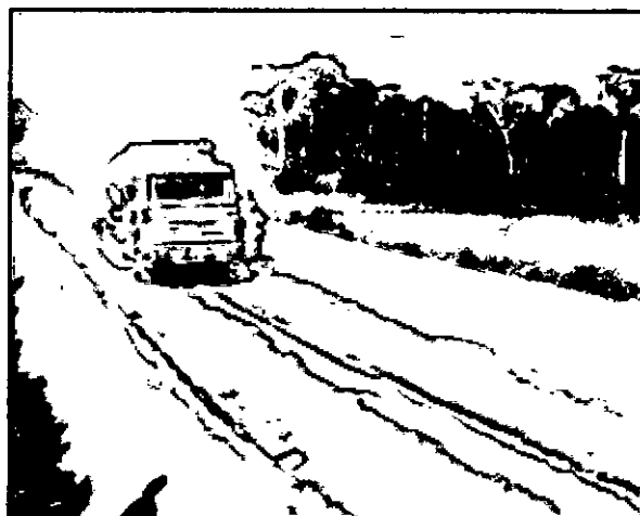
Figura 3-5: Esparcido de la cal con el camión dispensador.
