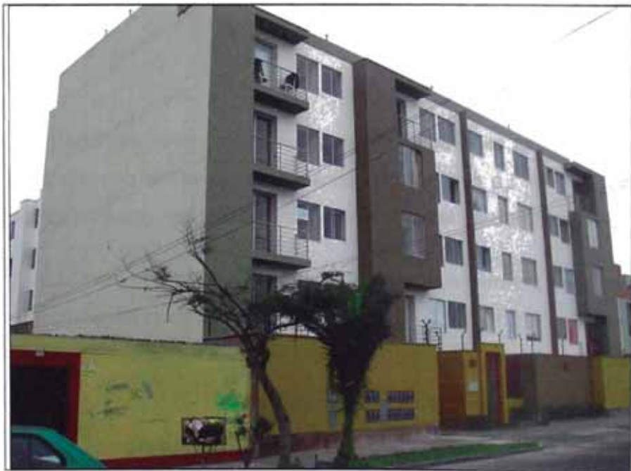
Figura 3-2: Fachada Principal – vista derecha
