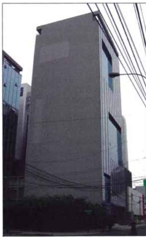
Figura 3-42: Fachada Principal – vista derecha
