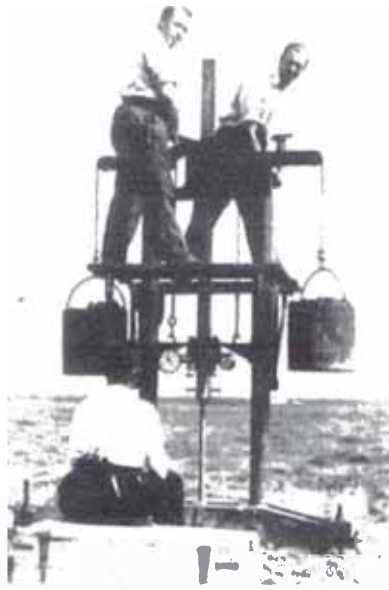
Figura 1.2: Principio mecánico de cono holandés (Delft Geotechnics)
