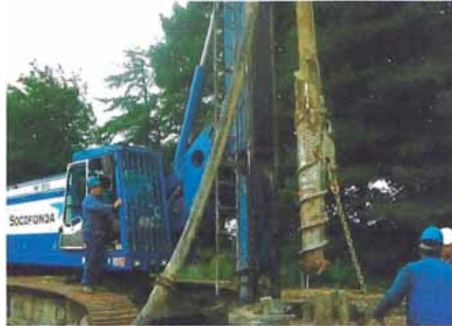
Figura 3.5: Pilote tornillo Omega.
