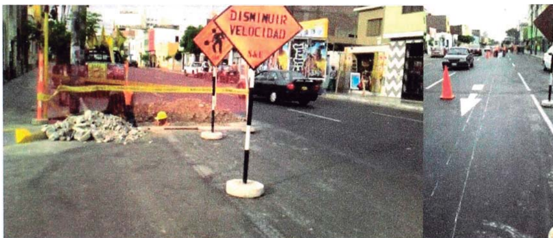
Foto 18. Sondeos, trazo y replanteo.
