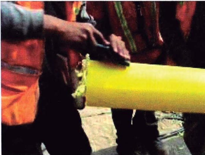
Foto 8. Raspado de extremo de tubería. Fuente: Manual de Construcción de Redes de Calidda.
