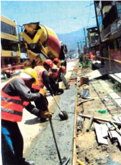
Foto 24. Reposición de concreto.
