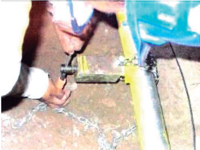
Foto 16. Perforación con sacabocado.
