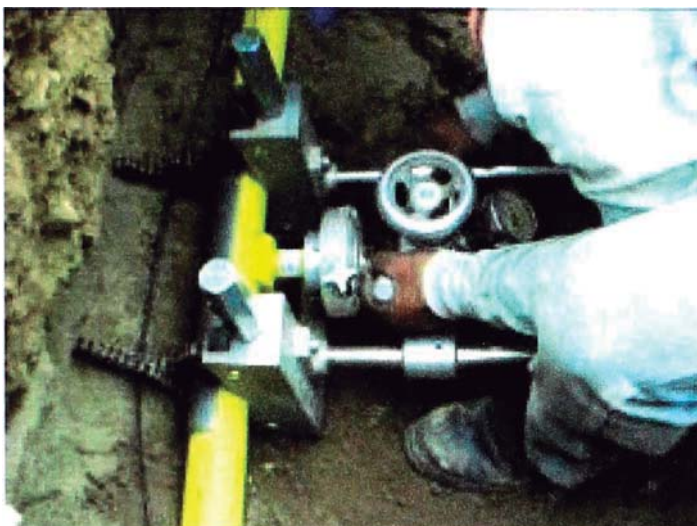
Foto.15. Termofusión de silleta para derivación.
