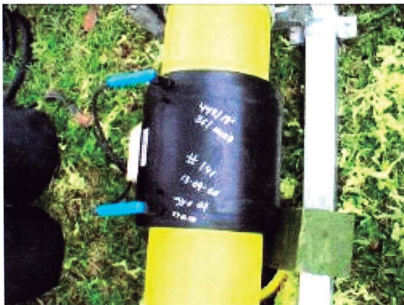
Foto 13. Marcado del accesorio con datos de la fusión.
