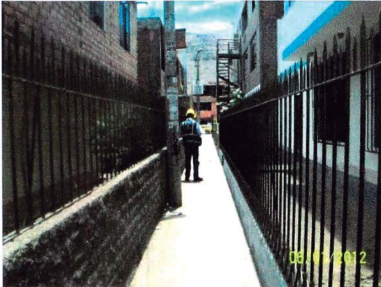
Foto 31. Pasaje con espacio limitado para la red de gas.
