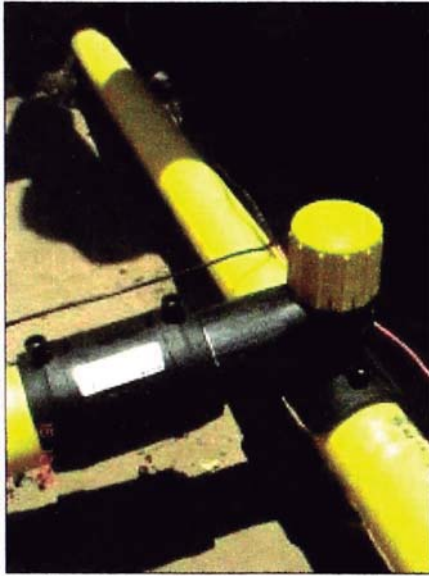
Foto.14. Montura de derivación de red.
