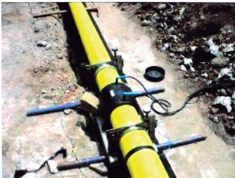
Foto.12. Proceso de soldadura de la unión.
