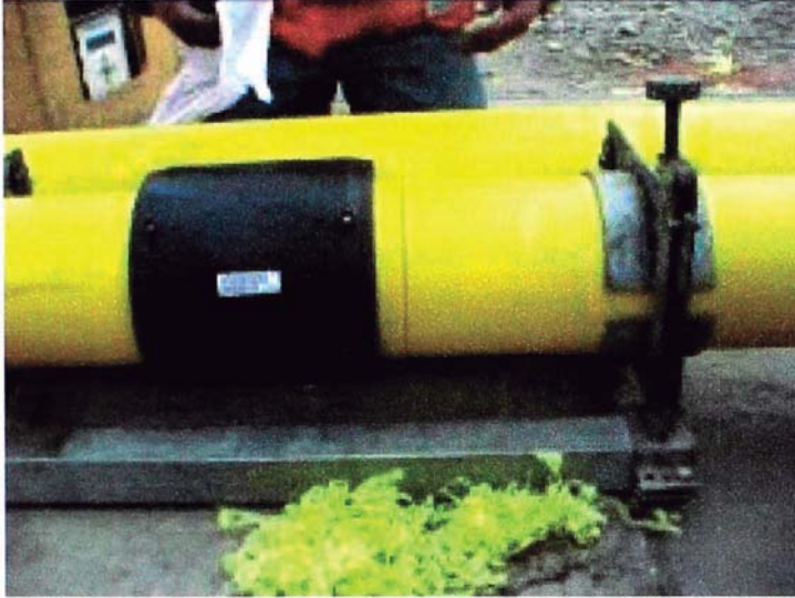
Foto 11. Preparación para la soldadura de unión.
