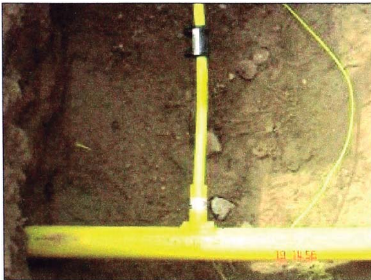
Foto 17. Termofusion a socket entre silleta y tubería de 20mm.
