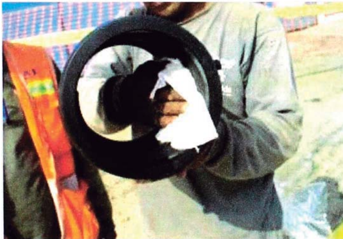
Foto 10. Limpieza interna (superficie a soldar) del accesorio.
