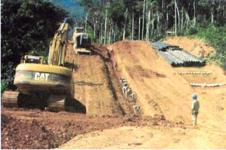
Foto 4. Trabajos de instalación de ductos.
