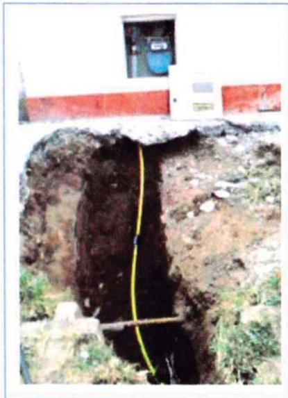
Foto 29. Línea de conexión que cruza interferencia eléctrica.
