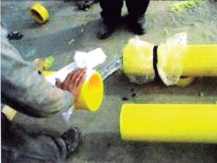
Foto 9. Limpieza y protección de la superficie.
