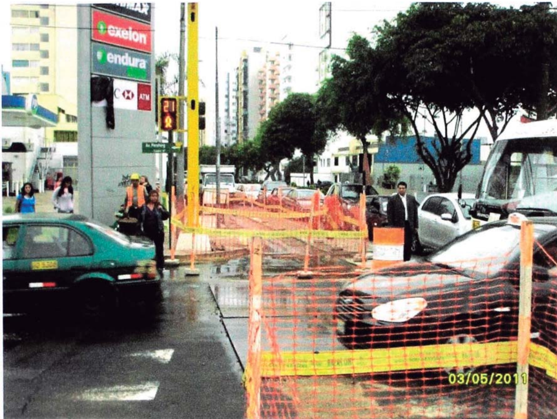
Foto.33. Trabajos en la vía pública.
