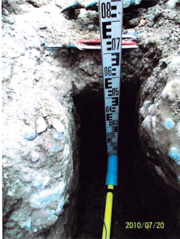
Foto 22. Tubería de polietileno cumpliendo la separación mínima a interferencias. Fuente: el Autor.
