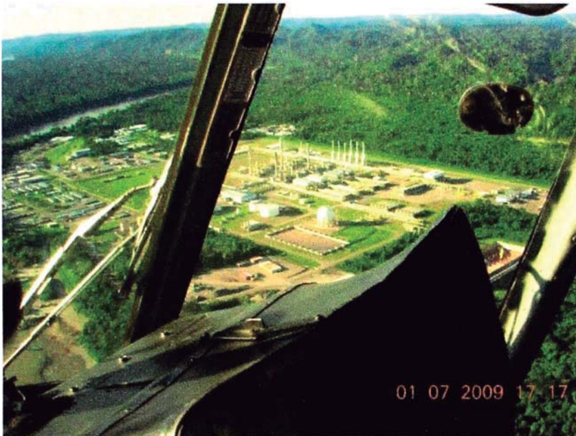
Foto 3. Planta de Separación en Malvinas.
