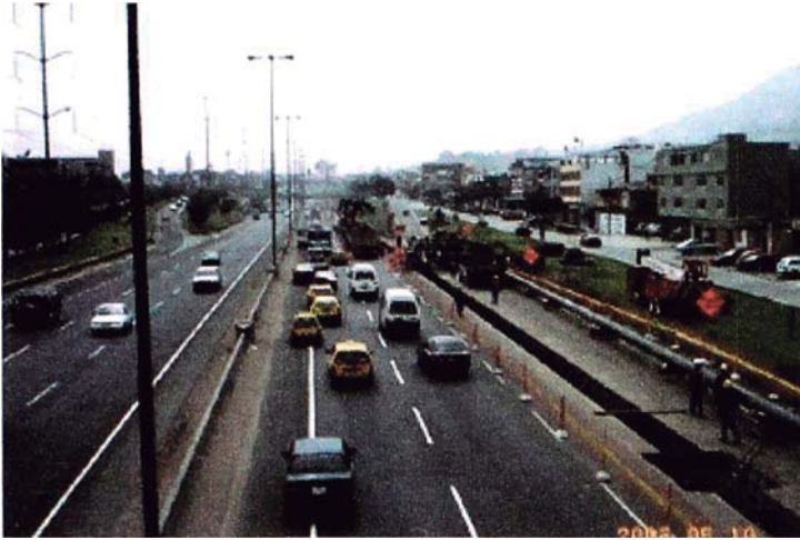
Foto.5. Obras de construcción en la ciudad de Lima.
