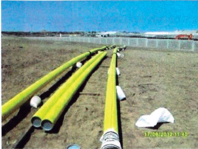
Foto 27. Habilitado y traslado de tuberías.
