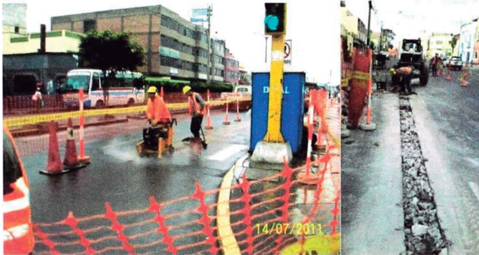
Foto.19. Corte y rotura de pavimento.
