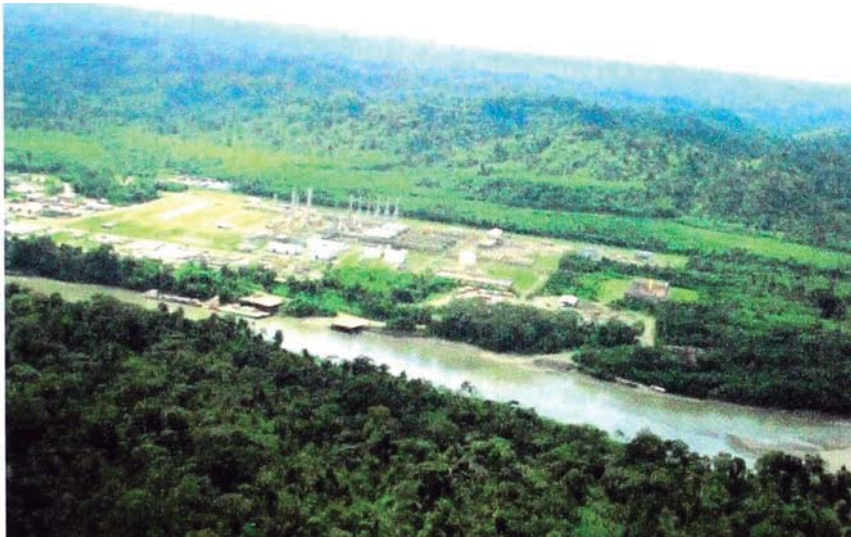
Foto 2. Planta de Separación en Malvinas.
