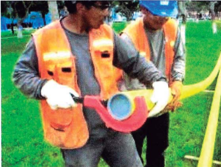
Foto 7. Uso de cortatubo. Fuente: Manual de Construcción de Redes de Calidda.
