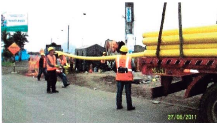
Foto 26. Traslado y habilitado de tuberías.
