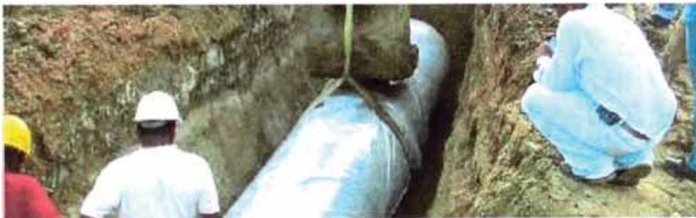
Figura 5 3 – Funda de polietileno alrededor del tubo de Hierro Dúctil
