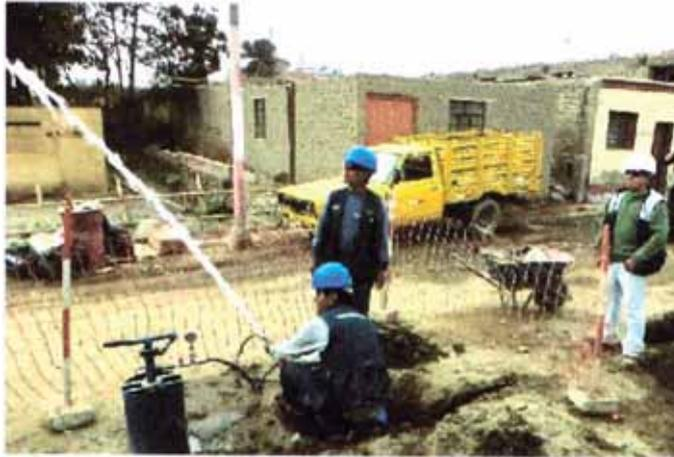
Figura 5 8 – Prueba hidráulica a Zanja Tapada
