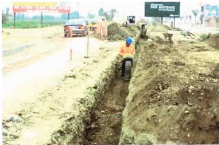
Figura 5.7 – Relleno compactado por capas
