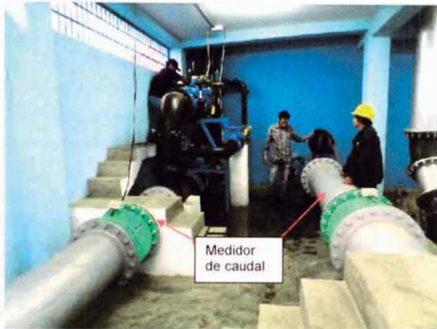
Figura 6 4 – Medidor de caudal electrónico
