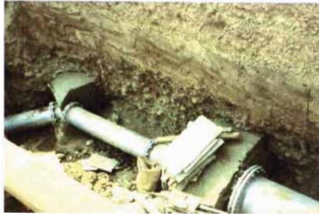
Figura 5 6 – Anclaje de accesorio de Hierro Dúctil
