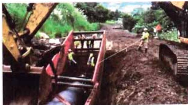
Figura 5 4 – Excavación y manipulación de la tubería de Hierro Dúctil
