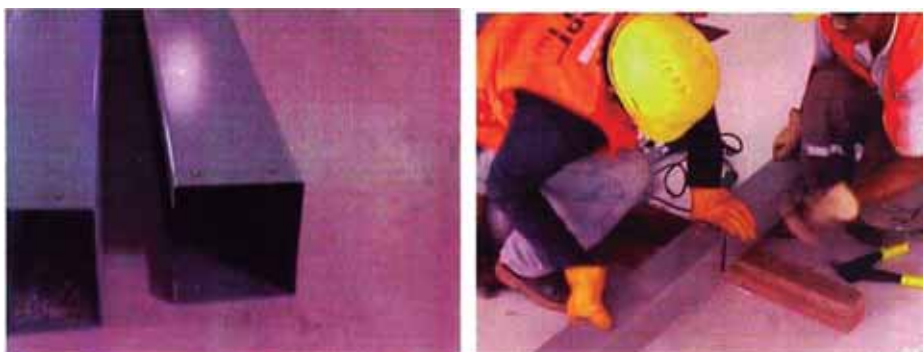
Fig. 4.29 Instalación de wire way
