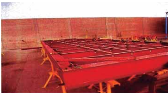
Fig. 4.17 Plataforma base soldada
