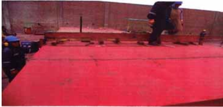
Fig. 4.18 Montaje de plancha de piso
