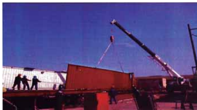
Fig. 4.20 Izamiento de pared
