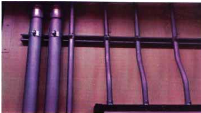
Fig. 4.33 Montaje de tuberías conduit
