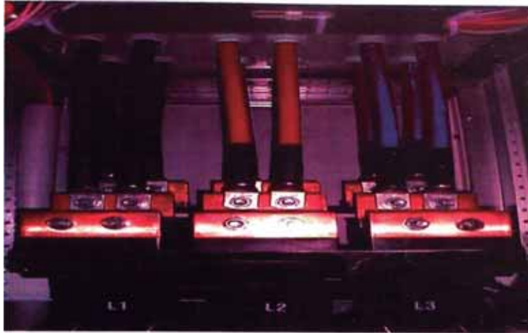
Fig. 4.51 Conexión de cables
