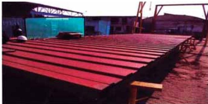
Fig. 4.19 Armado de pared
