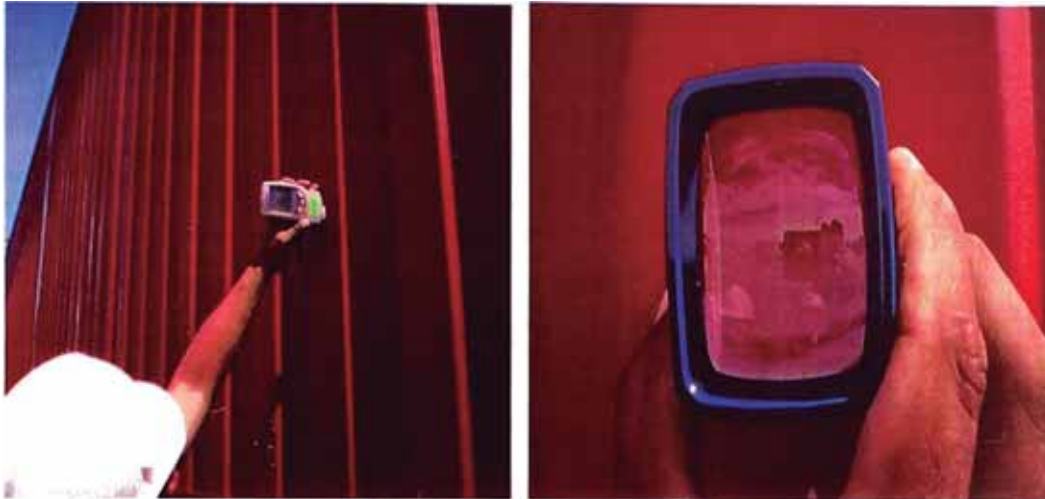
Fig. 4.58 Medición de espesor de pintura y prueba de adherencia
