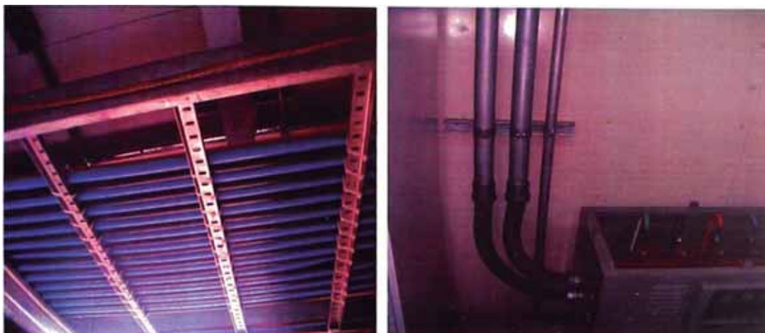
Fig. 4.47 Recorrido de cables
