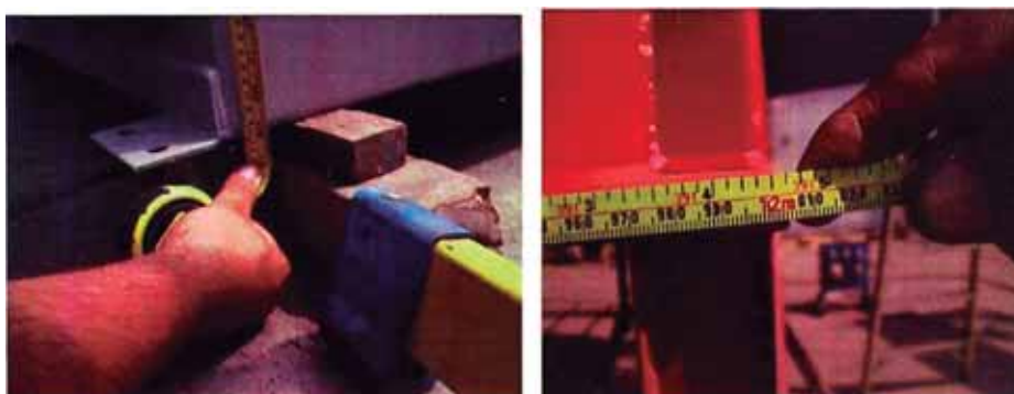
Fig. 4.57 Verificación de dimensiones de sala eléctrica
