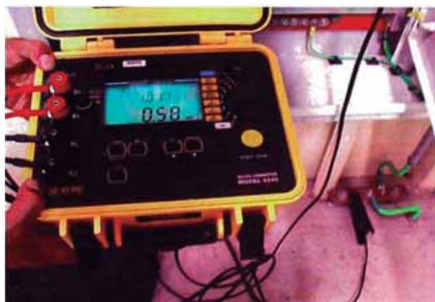
Fig. 4.53 Megado de cables
