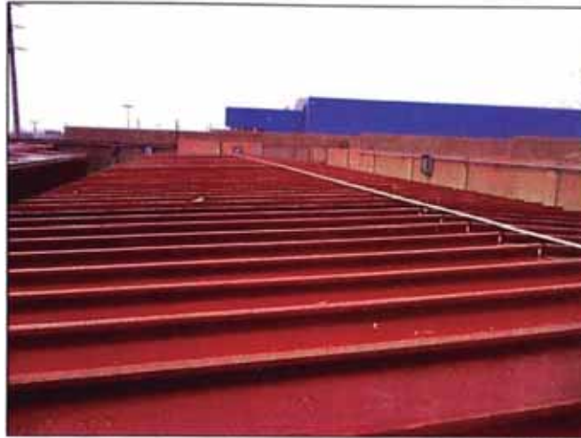
Fig. 4.24 Disposición de panel de techo
