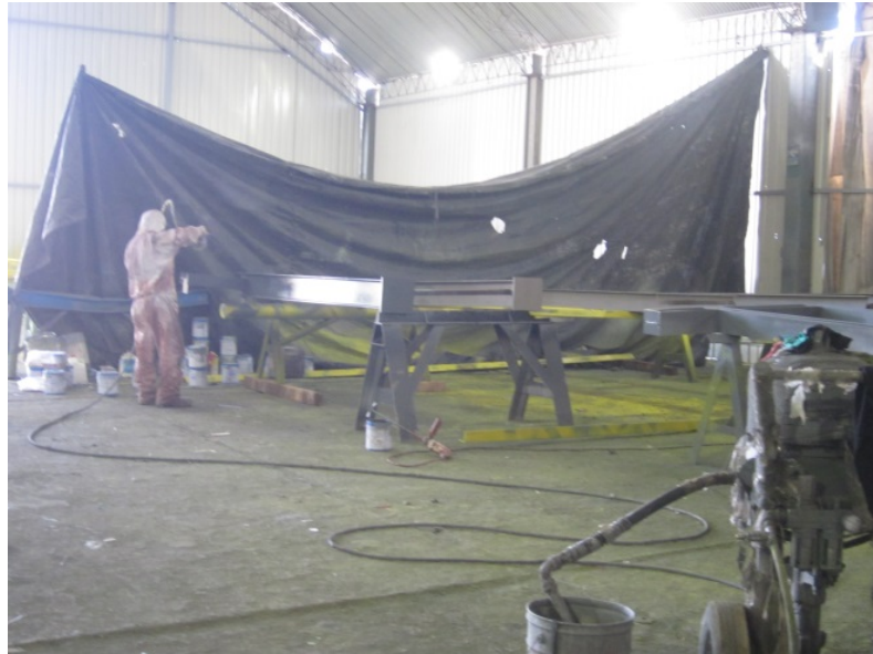
Figura 17. Aplicación del recubrimiento Fuente: Imágenes del taller FGA
