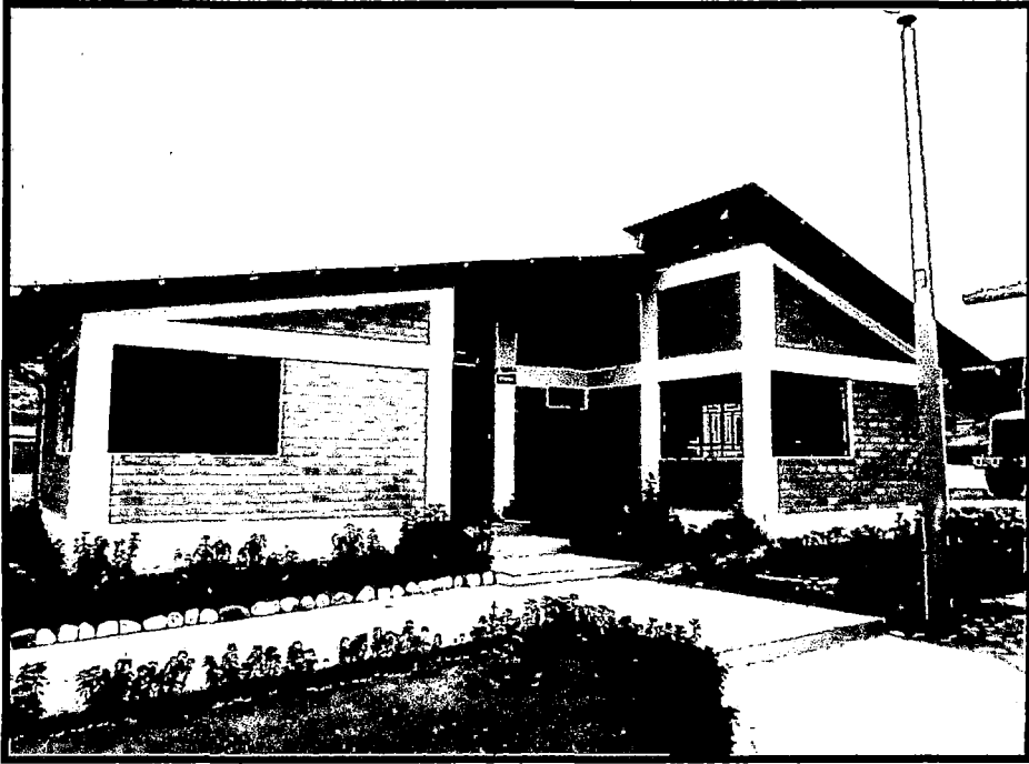
Fotografía Nro. 17: Oficinas en el relleno sanitario.
