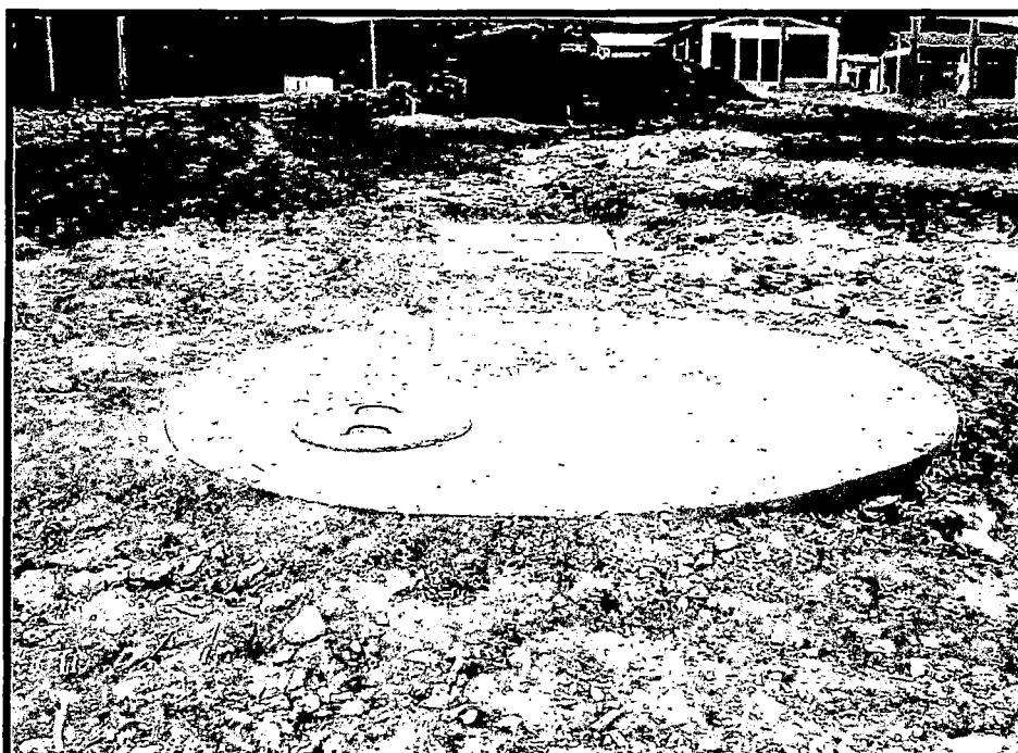
Fotografía Nro. 24: Pozo séptico y pozo de percolación.
