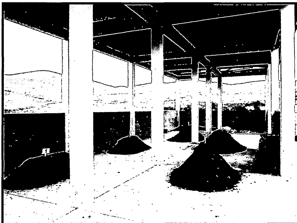
Figura Nro. 5: Rumas de compost en el almacén de compostaje.
