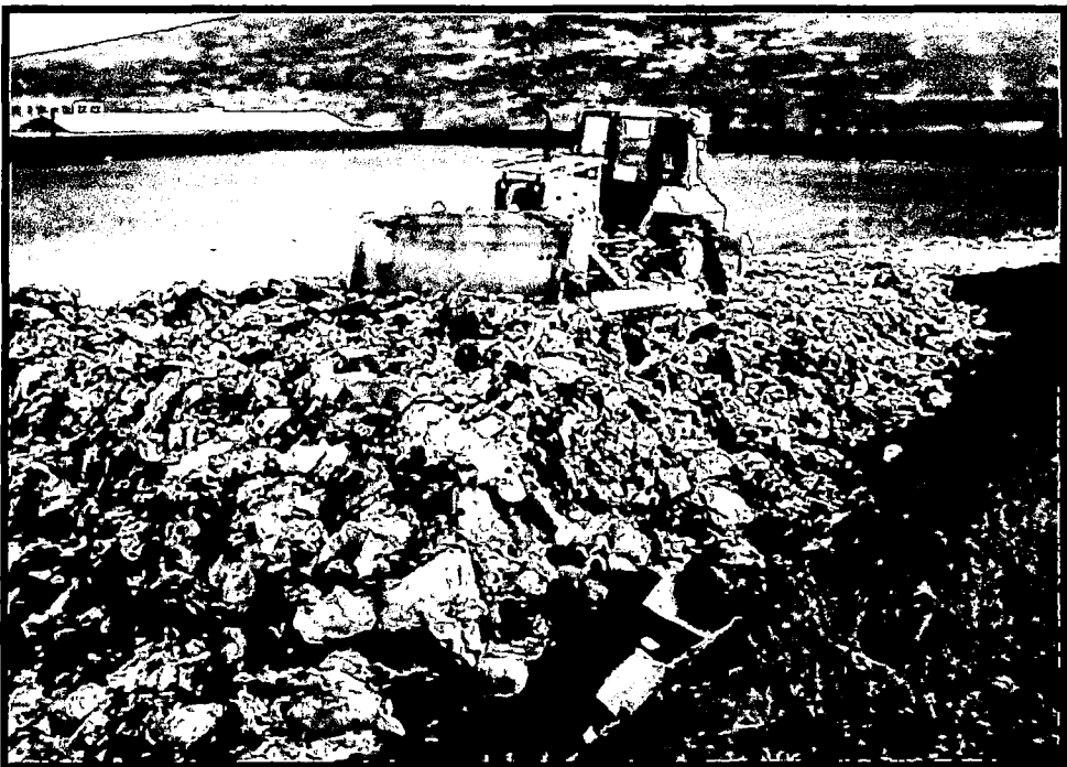
Fotografía Nro. 34: Extensión y compactación de los residuos sólidos.
