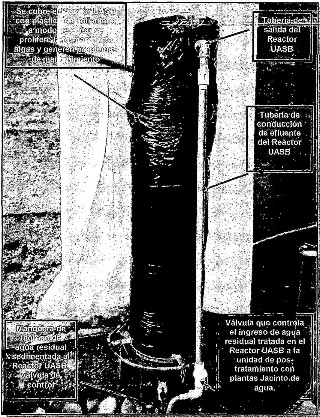
**Fotografía N° 21:** Reactor UASB protegido de la luz
