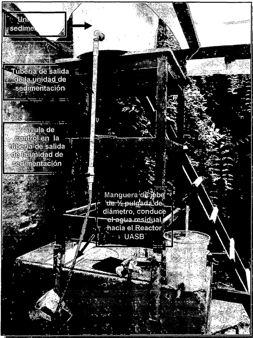
**Fotografía N° 05:** Base del tanque y tubería de conducción de las aguas residuales desde la unidad de sedimentación a la unidad de tratamiento Reactor UASB.
