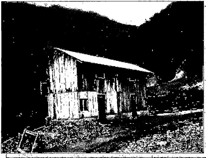
Foto 4.9: Vivienda reconstruida de dos pisos.
