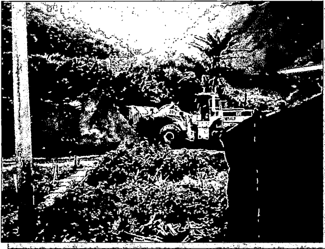
Foto 3.2: Afectación física por obras de ejecución – excavaciones.
