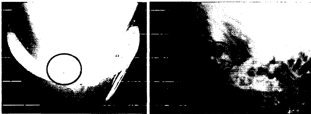
Figura 6.5.2. Detección del lavado de la tubería.
