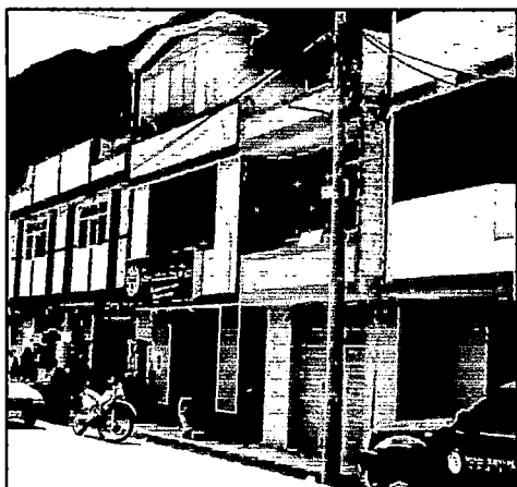
FIGURA N°117: Viviendas de albañilería confinada, año 2012.
