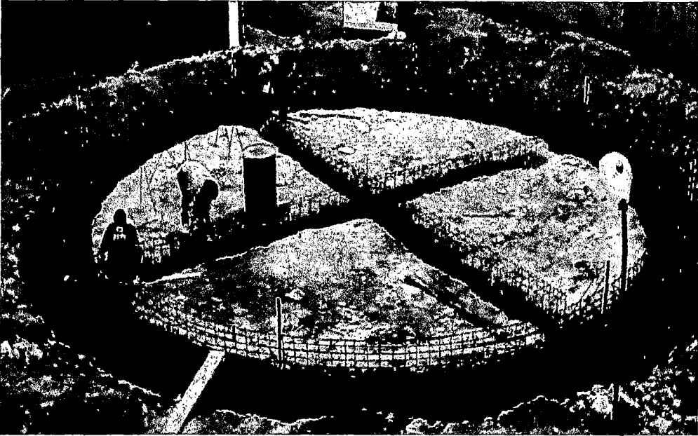
Fig.12.3 Construcción de los Cimientos de un Tanque Estacionario
