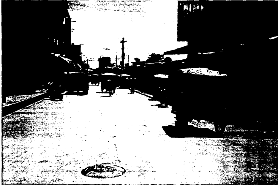
FIGURA 7.02: ZONA COMERCIAL JR. HUALLAGA
