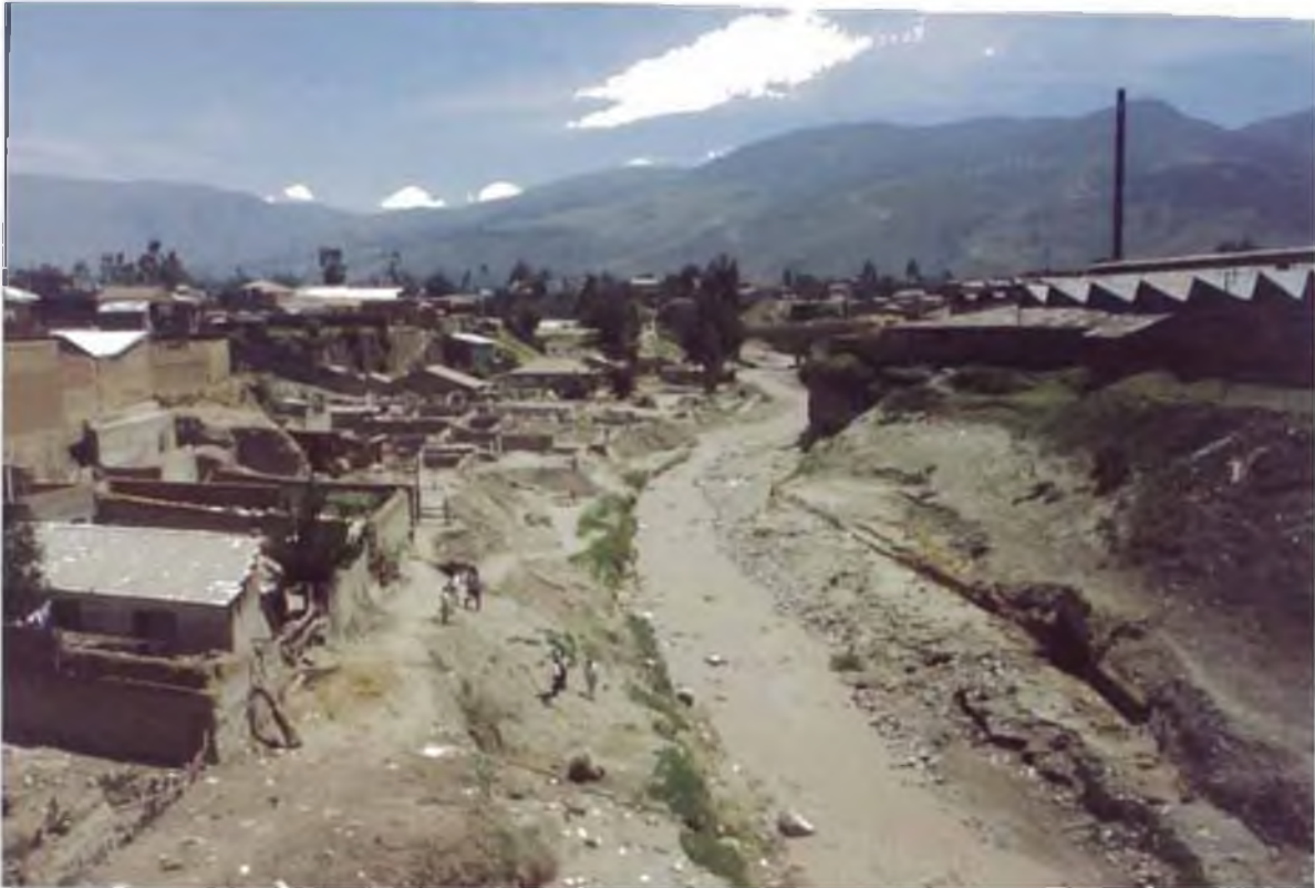
FOTO Nº 2.3: Aguas arribas del puente ferrocarril en la ciudad de Huancayo, lugar donde se produjo el represamiento del aluvión ocasionando destrucción en el asentamiento huamno Santa Rosa. (ENE -91).
