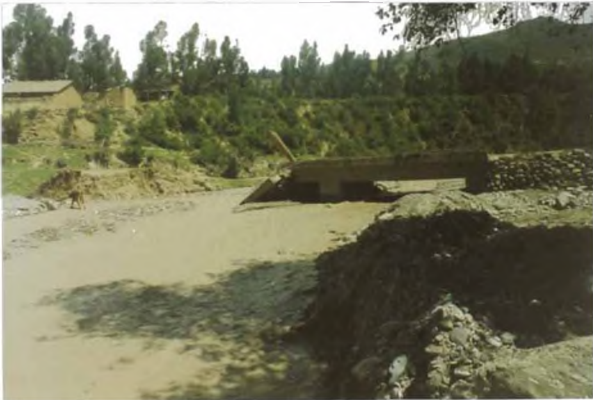
FOTO Nº 2.4: El puente ubicado en el anexo de Vilcañoto que servía de conexión entre la ciudad de Huancayo y las diferentes zonas rurales como la comunidad de Cochas fue arrasado por el aluvión, y las zonas rurales quedaron totalmente aisladas e incomunicadas. (ENE -91).
