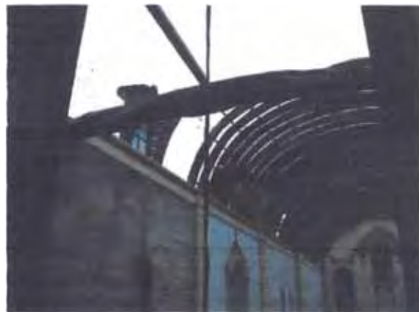
Imagen que muestra el interior del templo Sn Juan de Dios, se observa el empleo de materiales de la zona, tanto en la cúpula como en la viga, Madera huarango y recubrimiento en caña chancada.
