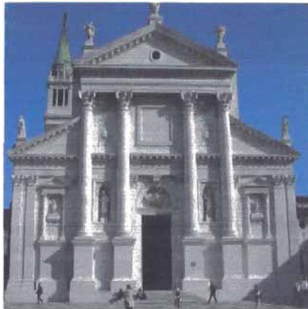
Imagen 7: Templo de San Giorgio Maggiore, de A. Palladio, Venecia. Este templo muestra los preceptos de arquitectura monumental. La verticalidad se acentúa con las pilastras, columnas, los basamentos elevados y la cúpula. La solides lo conforman varios contrafuertes laterales de la nave y finalmente el equilibrio se da por la simetría. Fuente: Manfred Wundram (1999): Andrea Palladio. ED. TASHEN. Ver pág. 150
