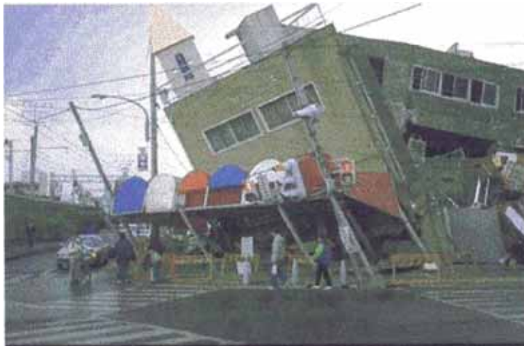
Figura 2.2 Colapso total producido por un sismo, en una edificación de dos niveles con un primer piso blando.
