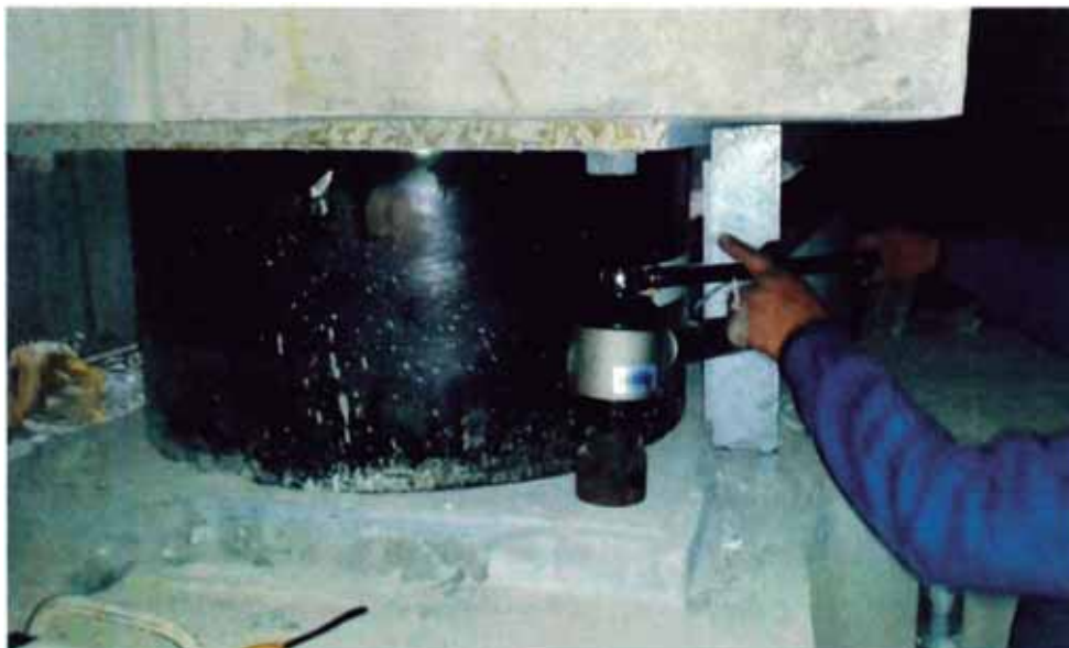
Figura N°60.- Aplicación de torque sobre pernos de aisladores (2)
