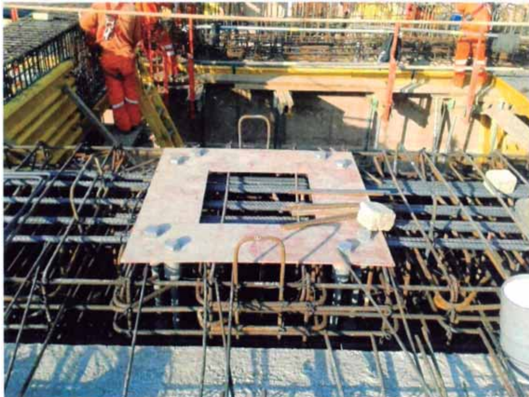
Figura N°64.- Plantilla de aisladores
