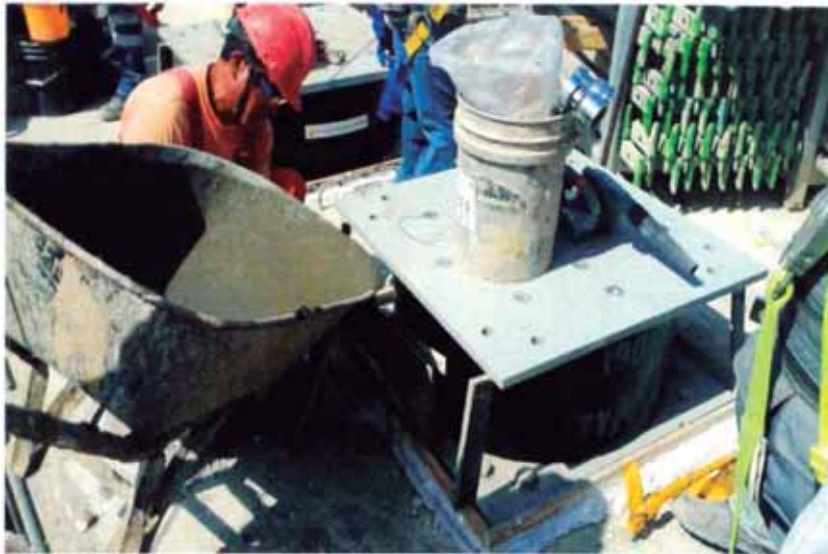
Figura N°48.- Aplicación de grout con embudo
