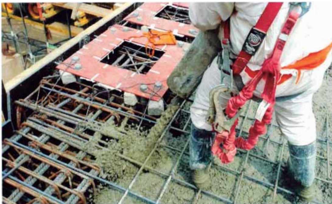
Figura N°37.- Vaciado pedestales de apoyo de aisladores
