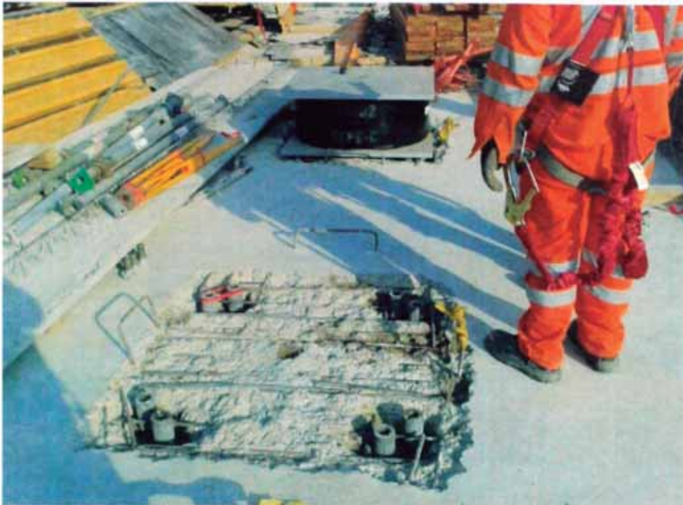
Figura N°40.- Pernos inferiores en el post vaciado
