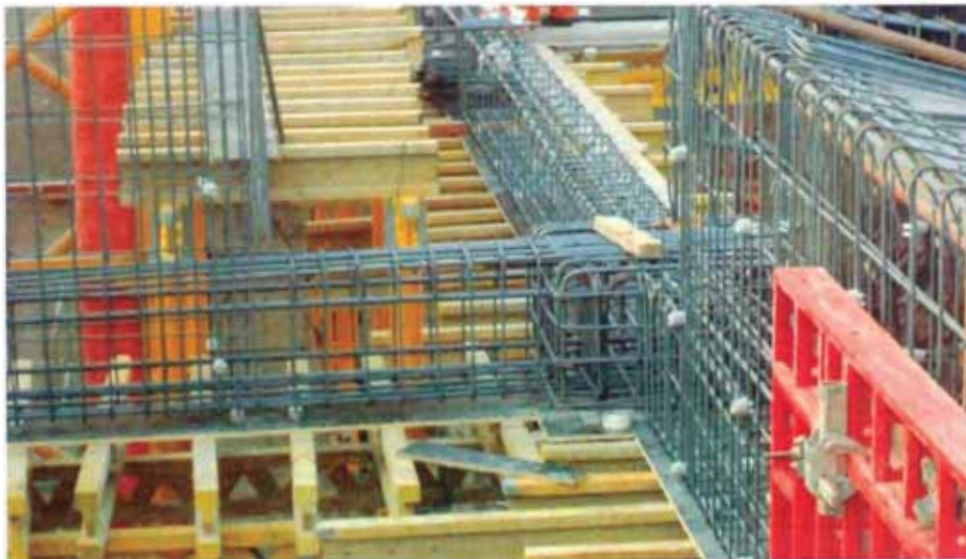
Figura N°29.- Acero de vigas de nivel inferior de aislamiento
