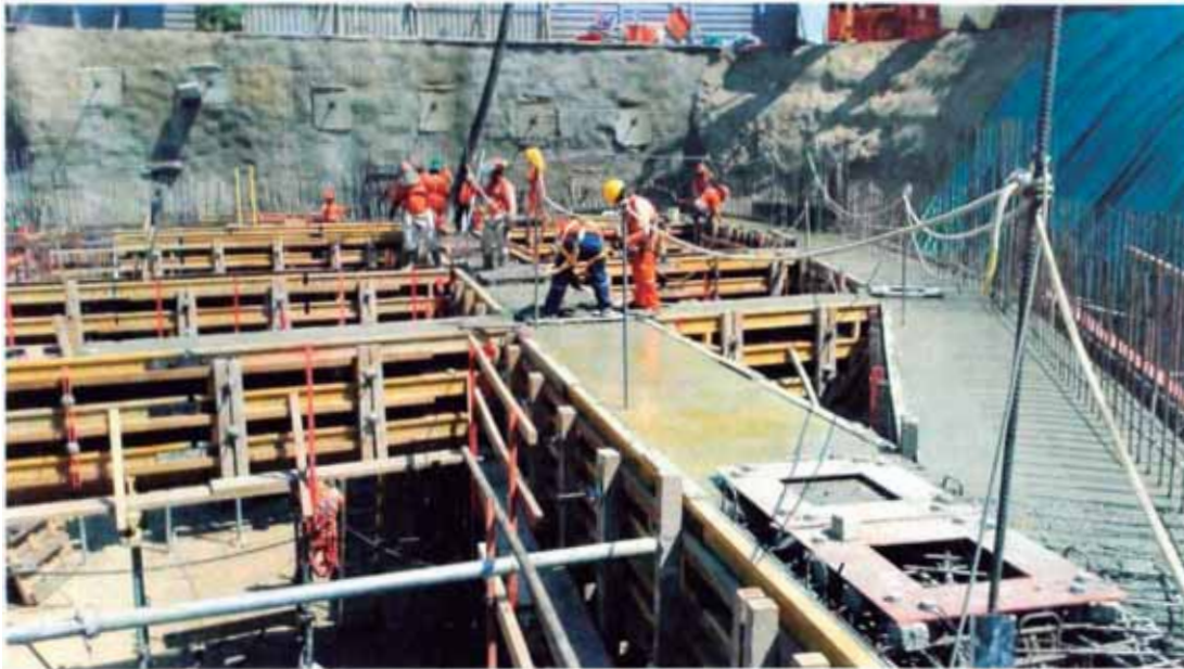
Figura N°36.- Vaciado de vigas de aislamiento y nivelación de plantillas
