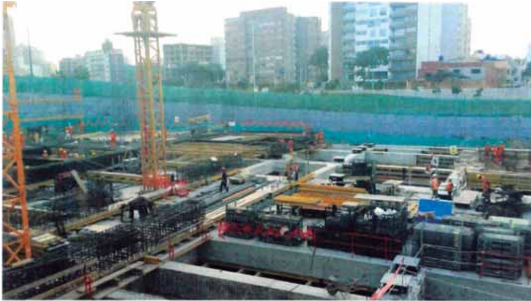
Figura N°56.- Planta general armado del nivel superior de aislamiento
