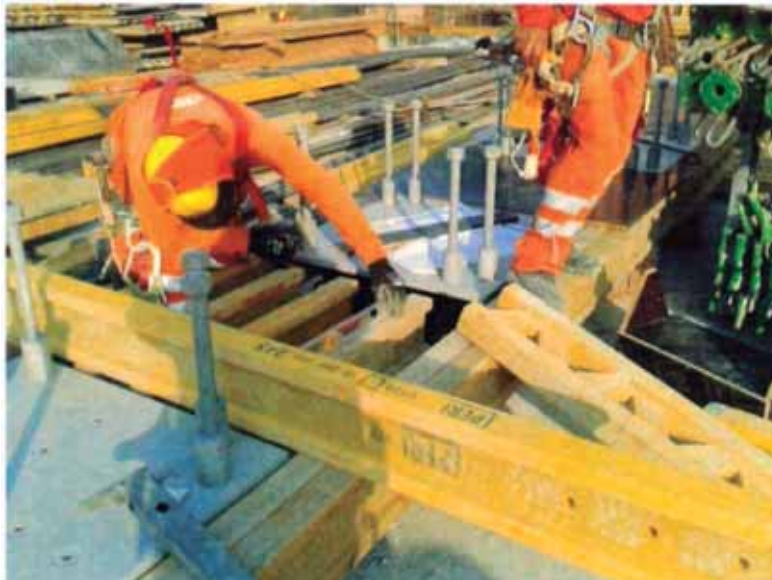
Figura N°51.- Colocación de fondo de viga
