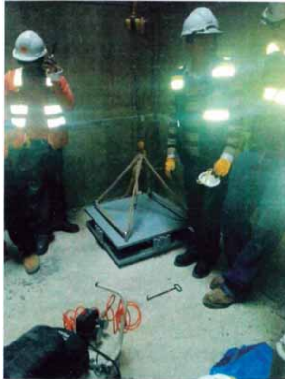
Figura N°8.- Deslizador sísmico
