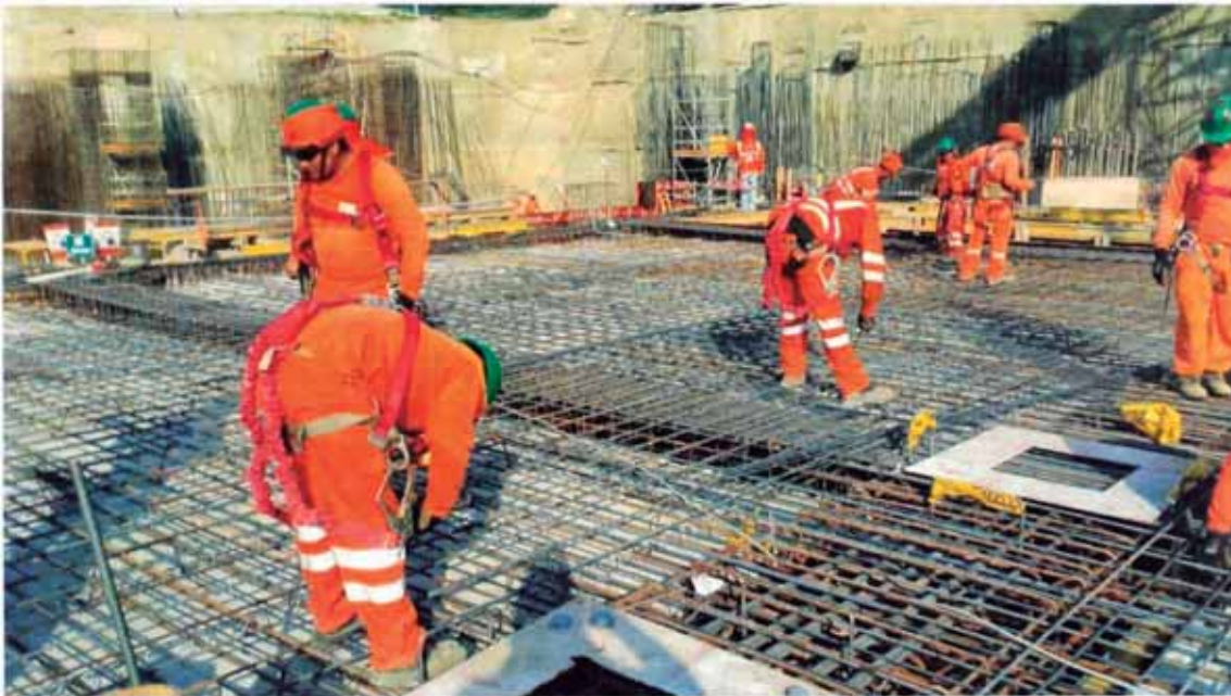
Figura N°63.- Colocación de plantillas de aisladores
