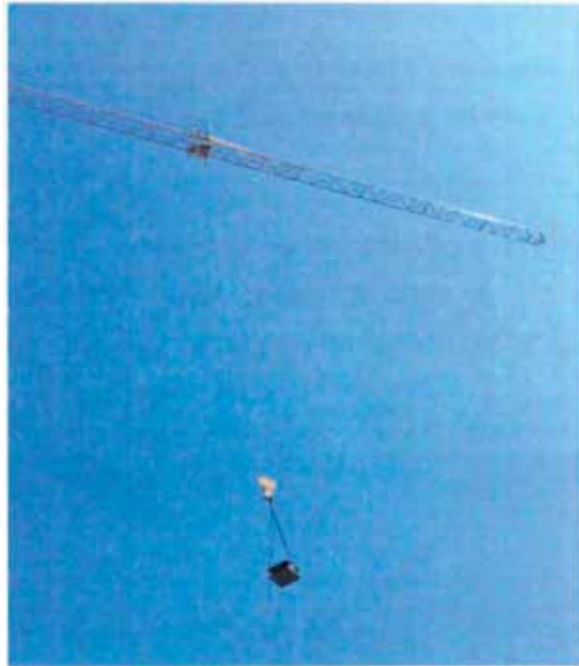
Figura N°41.- Izaje de aisladores con Grúa Torre
