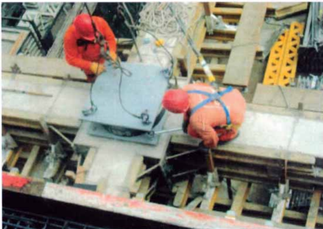
Figura N°42.- Montaje de aisladores sísmicos
