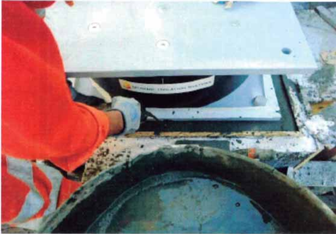
Figura N°46.- Aplicación directa de grout
