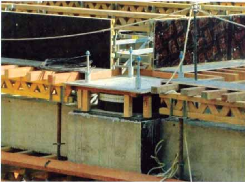
Figura N°50.- Pernos superiores colocados
