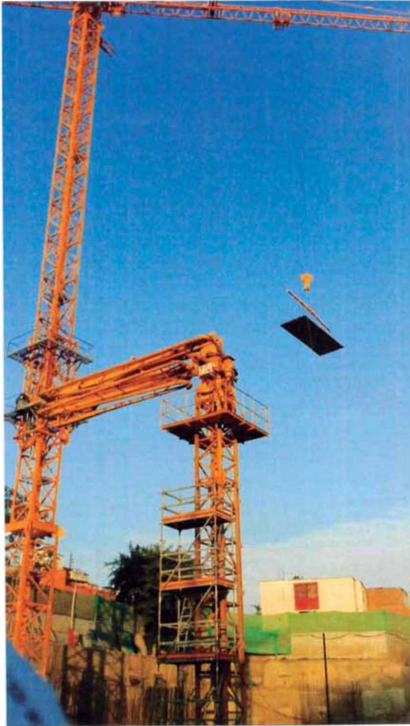
Figura N°66.- Izaje de prelosas
