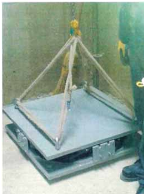
Figura N°16.- Deslizador sísmico
