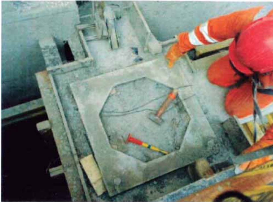
Figura N°39.- Retiro de plantillas de aisladores
