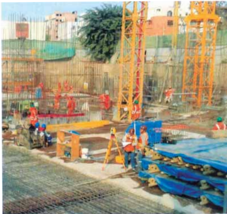
Figura N°73.- Cuadrilla de topografía durante el post vaciado
