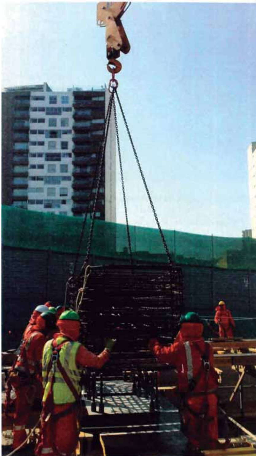
Figura N°55.- Colocación de pedestal prearmado sobre aislador sísmico
