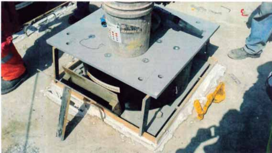
Figura N°47.- Embudo preparado en obra para aplicación de grout
