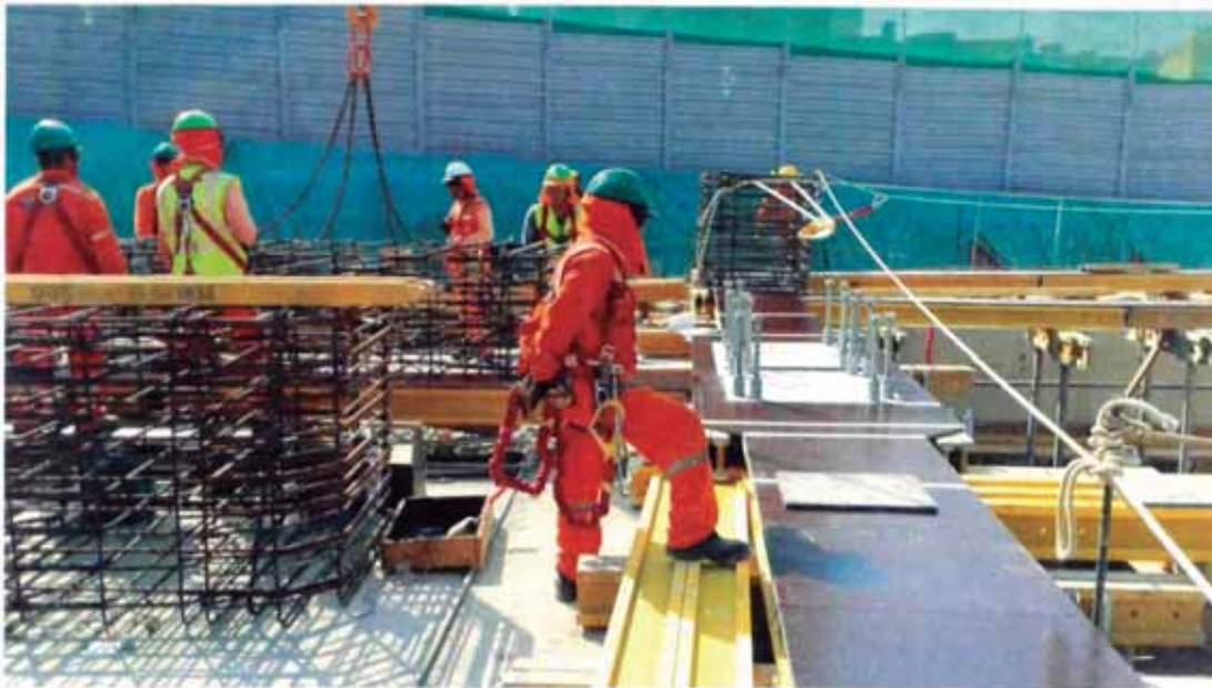
Figura N°52.- Fondo de viga armado
