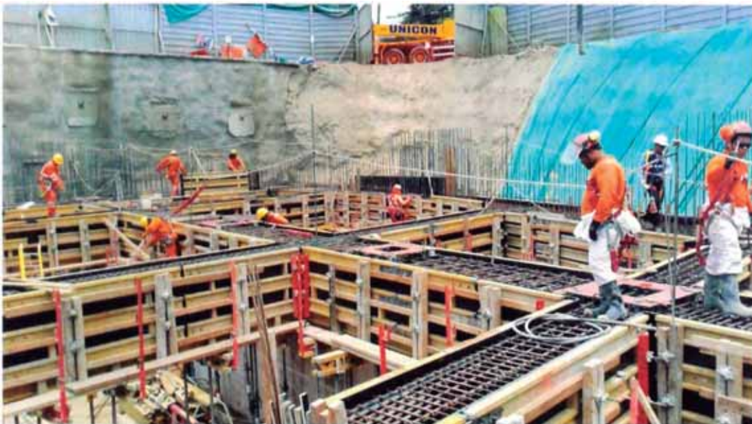
Figura N°34.- Nivel inferior de aislamiento con pedestales instalados listo para recibir el concreto
