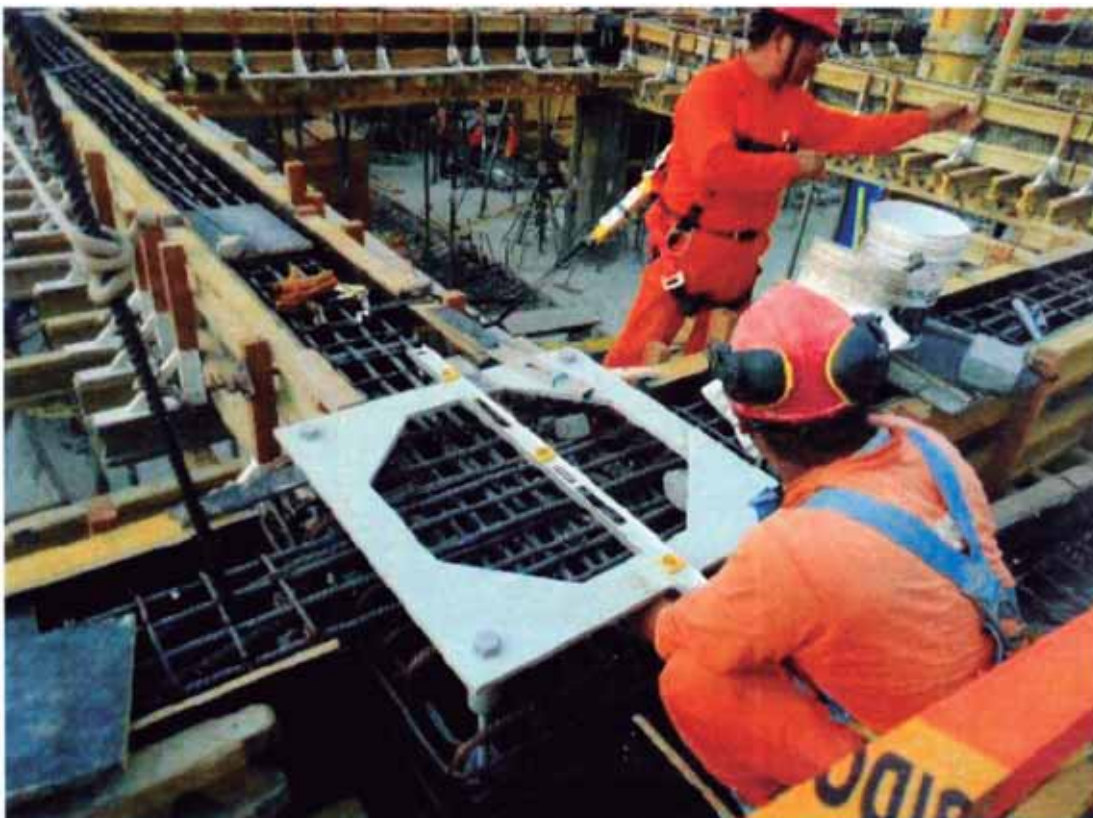
Figura N°32.- Nivelación de plantillas de aisladores
