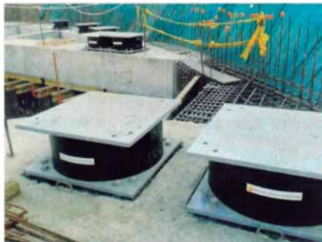
Figura N°1.- Aisladores sísmicos
