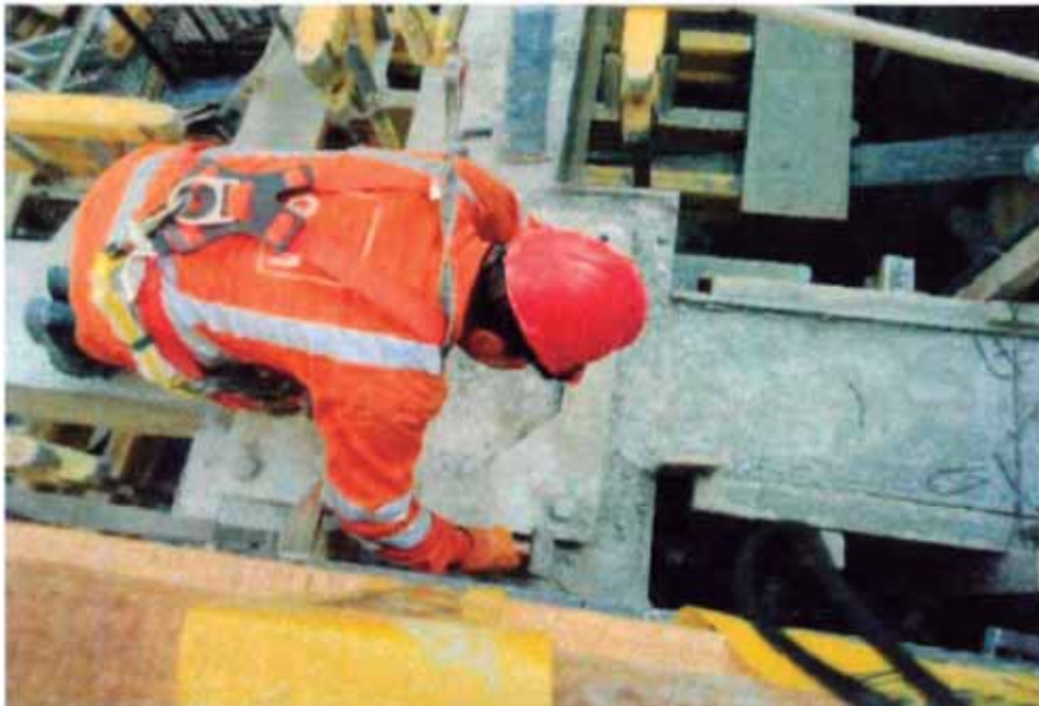
Figura N°38.- Retiro de plantillas de aisladores
