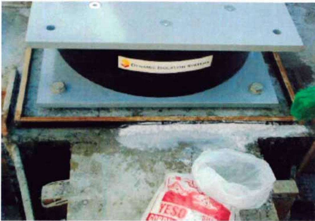
Figura N°45.- Encofrado para grouteado de aisladores
