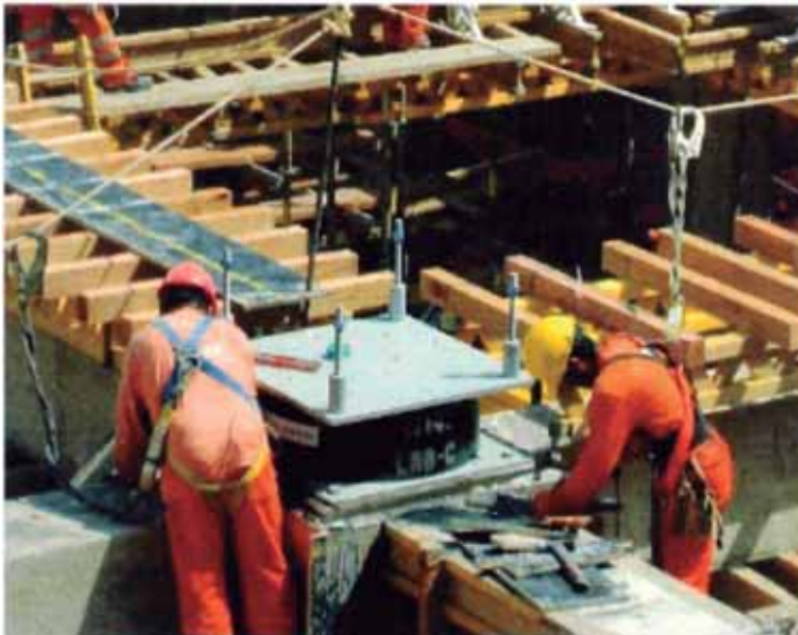
Figura N°49.- Colocación de pernos superiores en aisladores sísmicos
