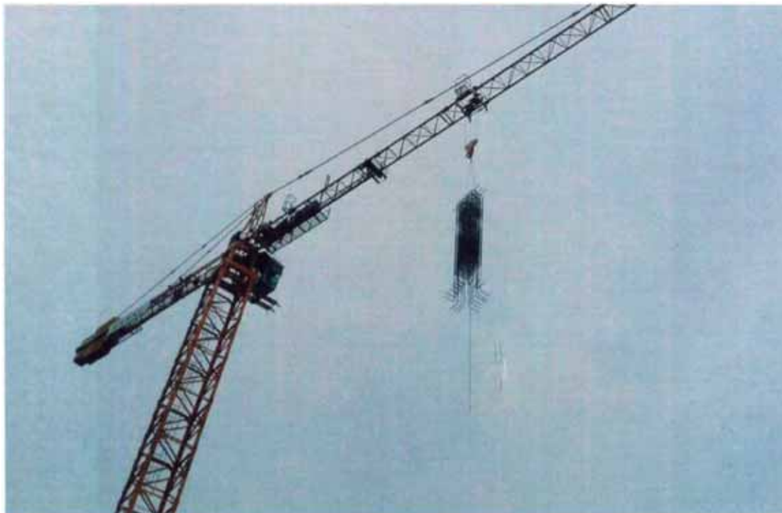
Figura N°65.- Izaje de prearmados de acero - verticales
