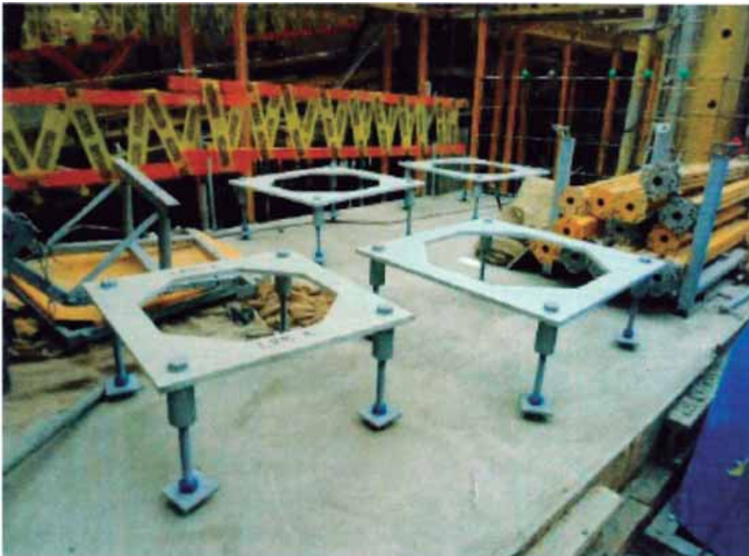
Figura N°30.- Plantillas para ubicación de pernos inferiores de aisladores
