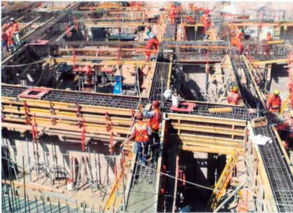
Figura N°72.- Cuadrilla de topografía durante el proceso de vaciado
