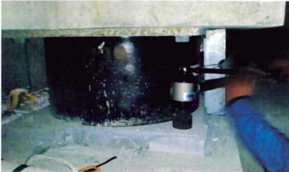
Figura N°59.- Aplicación de torque sobre pernos de aisladores (1)
