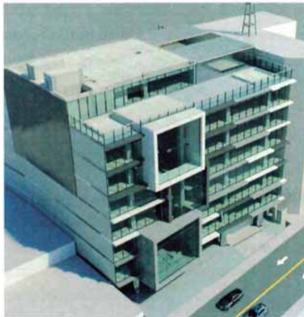
Figura N°10.- Nuevo edificio corporativo Graña y Montero
