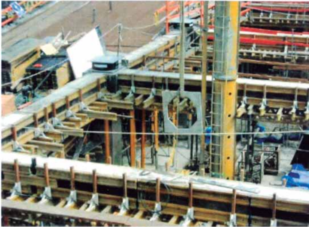
Figura N°31.- Izaje de plantillas para base de aisladores
