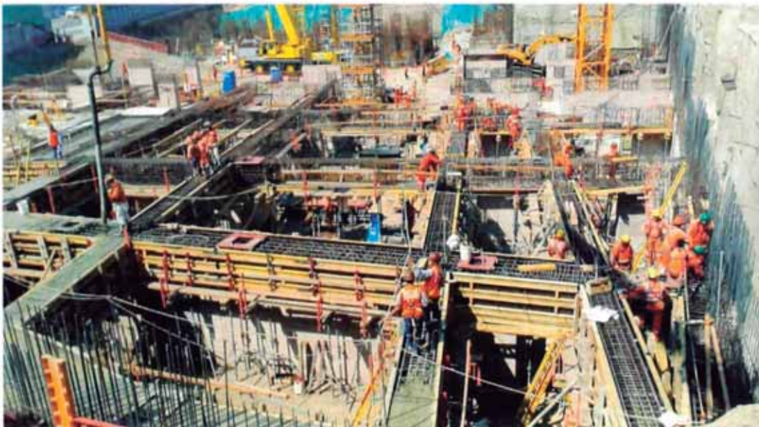
Figura N°35.- Vaciado de nivel inferior de aislamiento
