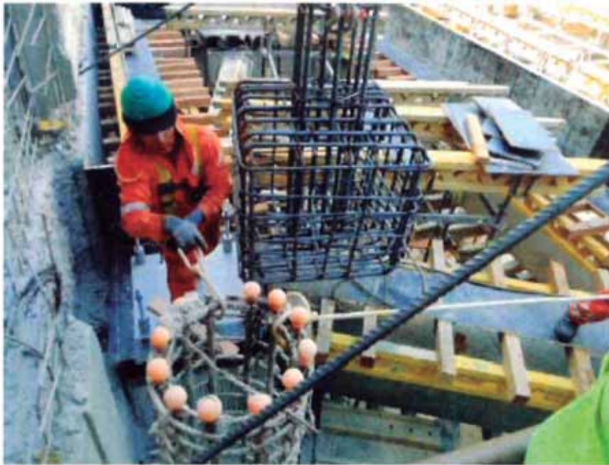
Figura N°53.- Izaje de columna prearmada
