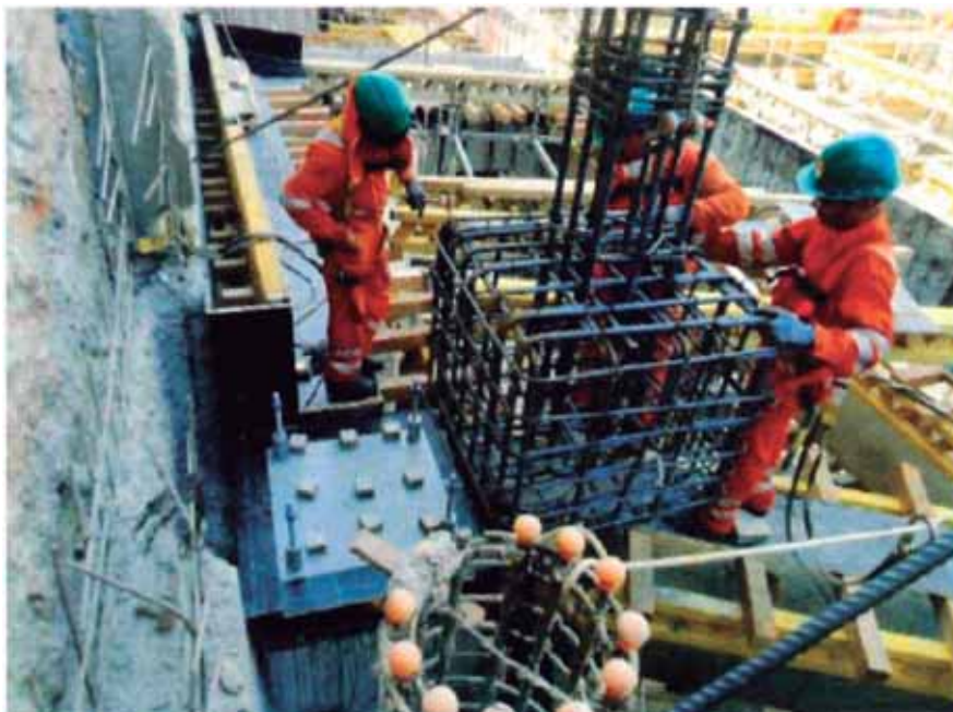
Figura N°54.- Colocación de columna prearmada sobre aislador sísmico
