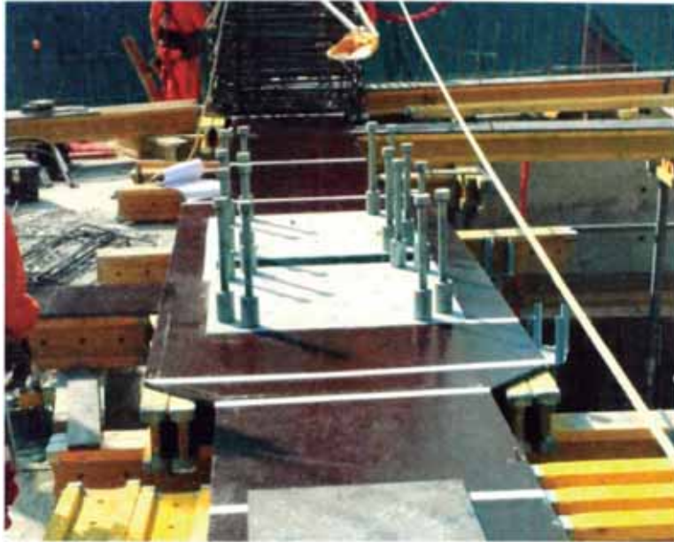
Figura N°3.- Pernos superiores colocados
