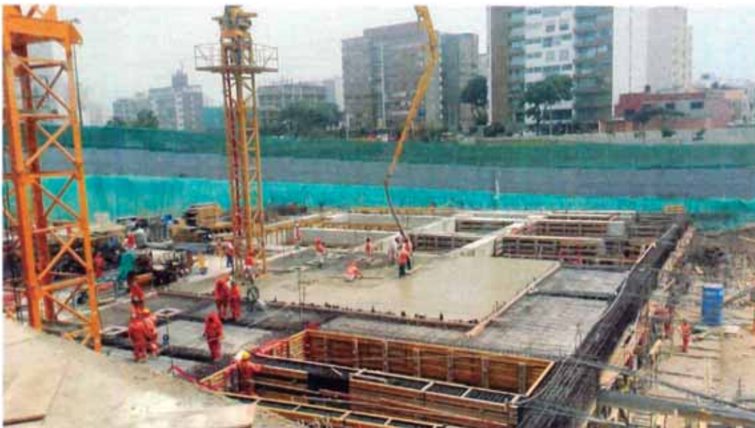
Figura N°57.- Vaciado de nivel superior de aislamiento
