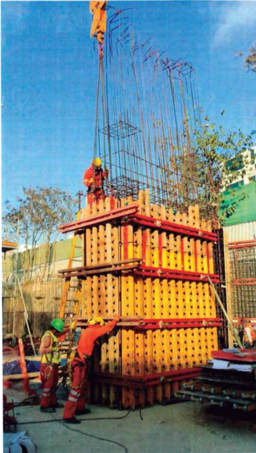
Figura N°67.- Izaje de prearmados de encofrado
