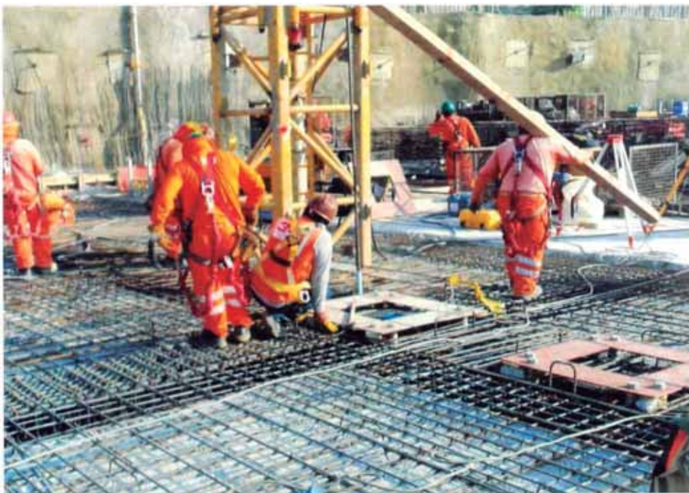
Figura N°71.- Cuadrilla de topografía antes del vaciado
