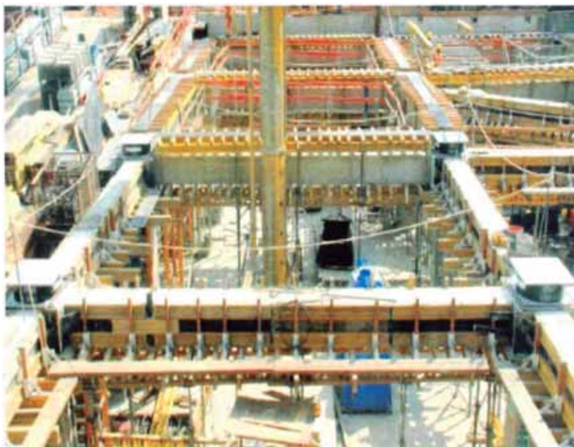
Figura N°4.- Sistema de aislamiento sísmico
