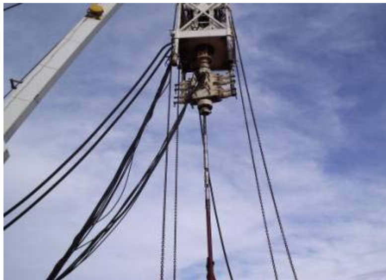
Conexion del Coiled tubing al Straddle Packer. El pozo continua abierto.
