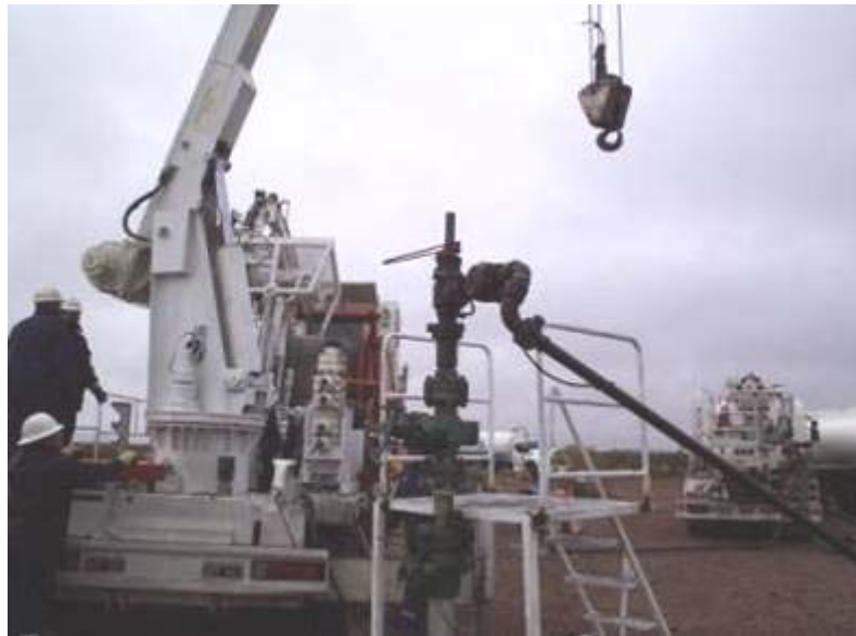
Straddle en Boca de pozo, mientras se levanta la cabeza de inyección y BOP con la Grúa. Pozo Abierto.
