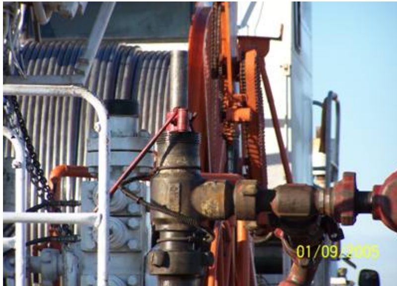
Straddle Packer dentro del pozo, colgado con una grampa.
