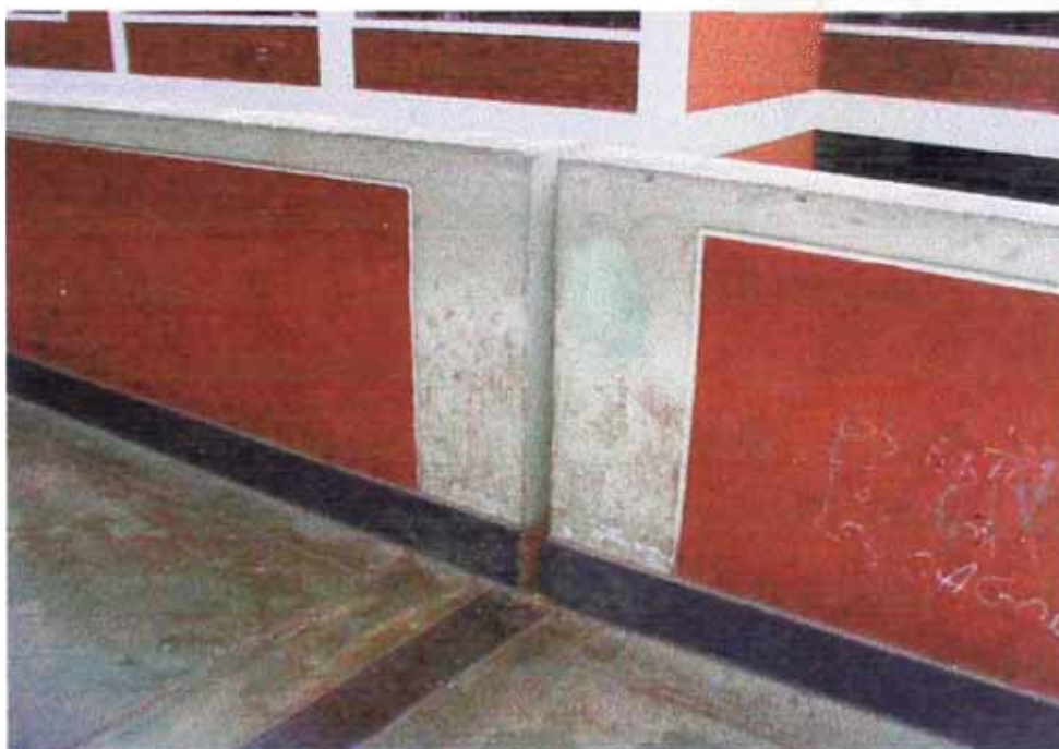
Figura 1.9 Vista Detallada de la junta entre Escalera y Edificación C.E. Julio César Escobar – San Juan de Miraflores.
