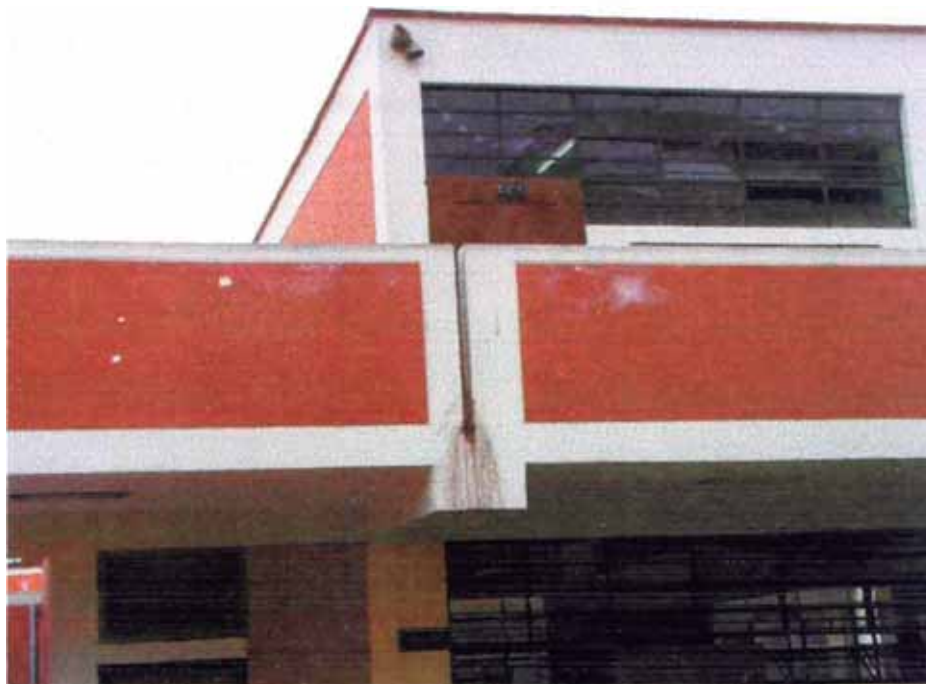
Figura 1.8 Vista Panorámica de la junta entre Escalera y Edificación C.E. Julio César Escobar – San Juan de Miraflores.
