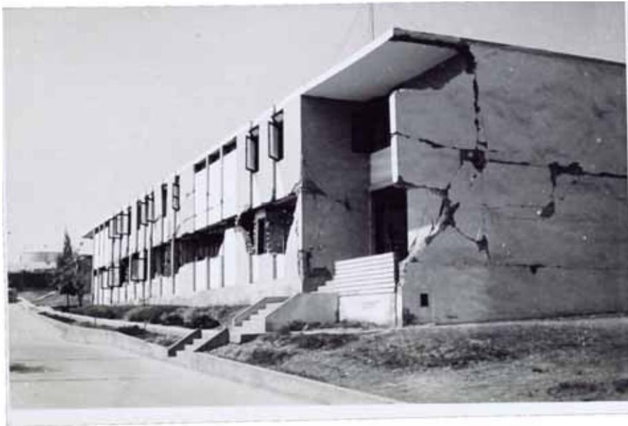
FOTO N° 1 PABELLON DE LA RESIDENCIA DEL PERSONAL Muestra el montículo y la pendiente del terreno sobre la que está construida la edificación.
