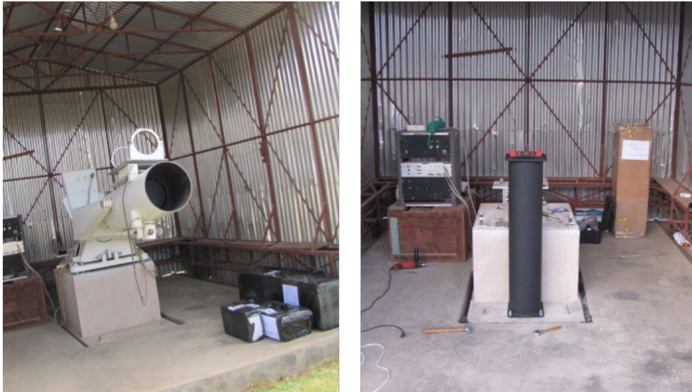
FIGURA 3.3: Misión 1. Inicios de los trabajos de instalación de los instrumentos en la caseta del telescopio. Desmontaje del astrógrafo e instalación del pedestal. Izquierda: astrógrafo sobre la fundación. Derecha: Pedestal sobre la parte baja de la fundación. Recortes de fotos tomadas por el Dr. Pereyra.
