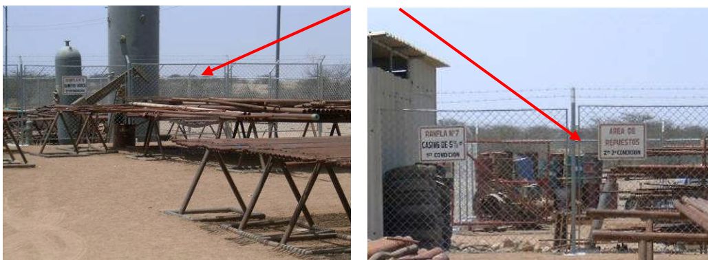
Fotografía N° 4-11 y 4-12 Patio de chatarra limitando con patio de tubos y repuestos
