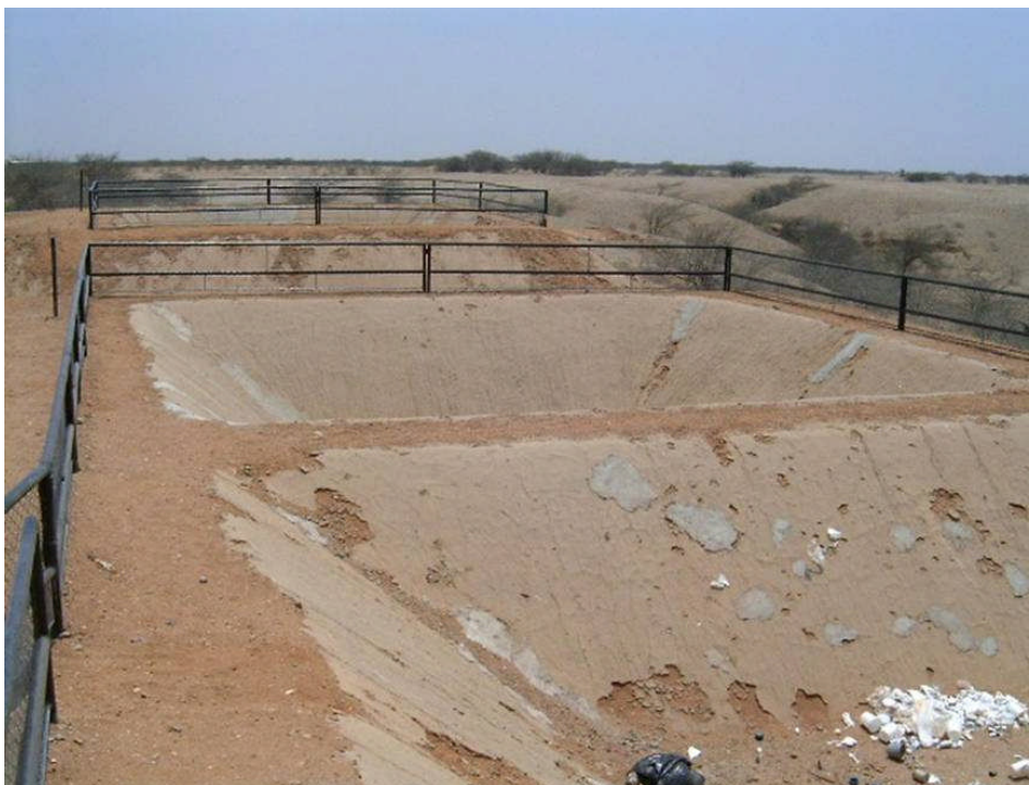
Fotografía N° 4-10. Se observa al fondo poza de borras y sedimentos, a continuación la de desechos peligrosos, y adelante la de no peligrosos
