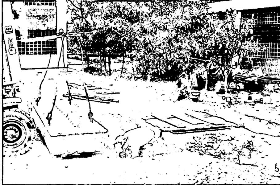
Figura 4.22. Trabajos iniciales de implementación de la viga de reacción.
