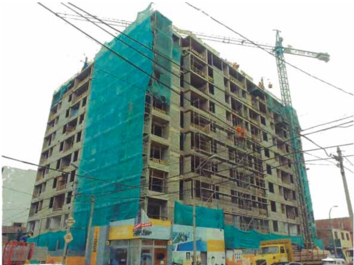
Figura N°16: Vista actual del proyecto "PUNTA CANA".
