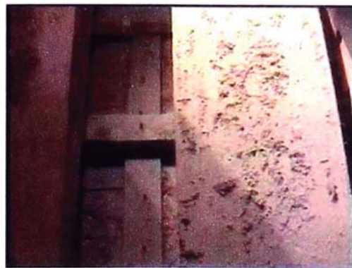
Foto A.26. Vista interior – Cobertura interior de madera de los arcos.
