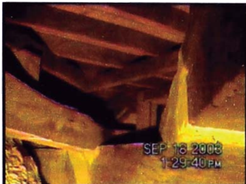
Foto A.21. Vista interior – Vigas de confinamiento de bóvedas apoyadas sobre las vigas principales del techo plano.
