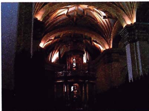
Foto 5.18. Vista interior de las bóvedas nervadas de madera.
