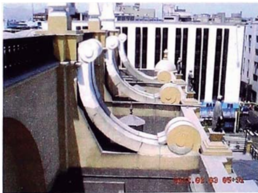
Foto A.62 Vista exterior de zona de arbotantes eliminados del lado de la puerta de los Judíos y hacia la parte posterior de la catedral. Nótese elementos decorativos de madera con cobertura exterior de madera y yeso.
