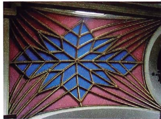
Foto 5.19. Vista de una bóveda. Obsérvese que no hay descascaramiento de la pintura por humedad.
