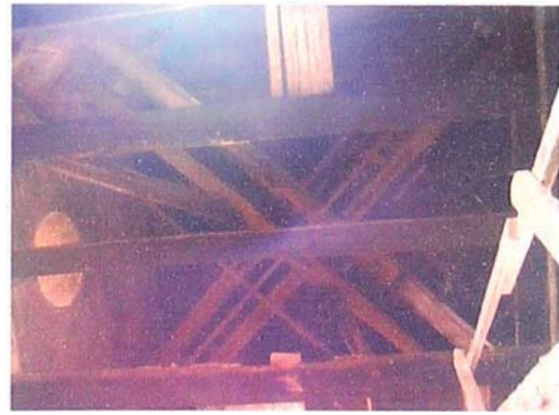
Foto A.47 Vista interior de estructuras de madera en la parte alta de las torres.
