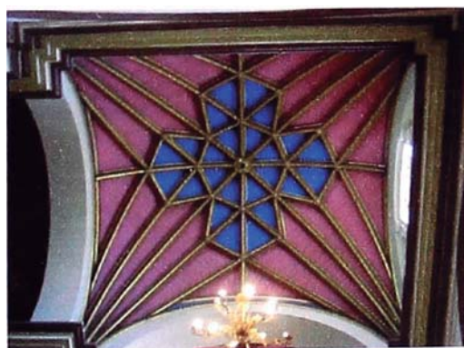
Foto A.30. Vista interior de bóvedas nervadas que muestra el estilo neo-gótico en forma de cruces de Malta.
