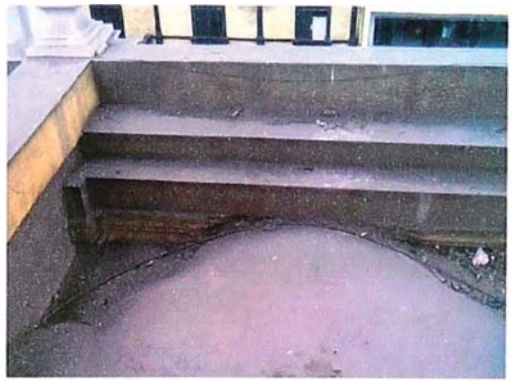
Foto A.37. Vista de cobertura exterior de las bóvedas nervadas, por debajo del techo. Vista exterior de bóvedas hacia el lado del muro postrero sobre la puerta de Santa Apolonia.
