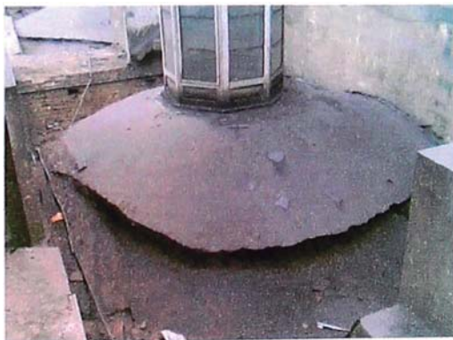
Foto A.36 Vista exterior de bóvedas de capillas ubicadas del lado de la puerta de los naranjos, cercanas a las torres.
