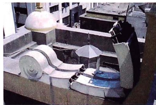
Foto 5.43. Falla de algunos elementos decorativos en la zona posterior de la catedral.
