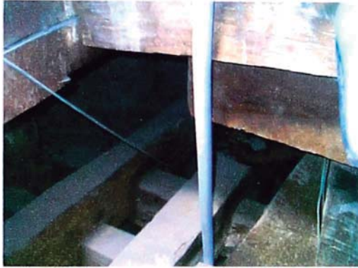
Foto A.17. Vista interior – Conectores horizontales de madera (4) que unen los puntales principales que se apoyan sobre los maderos de cerramiento de los pilares.
