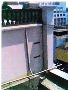
Foto A.52 Vista exterior de muro estribo ubicado en el crucero de la catedral (Eje 5) del lado de la puerta de los Judíos.
