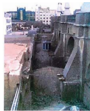
Foto A.63. Vista exterior de zona de arbotantes eliminados del lado de la puerta de los Naranjos y hacia las torres de la catedral..
