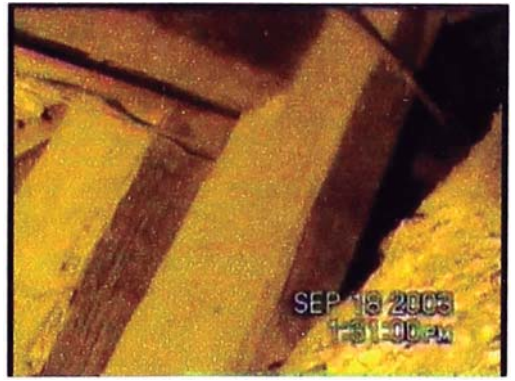
Foto A.20. Vista interior – Apoyos de las vigas principales del techo plano sobre las diagonales.
