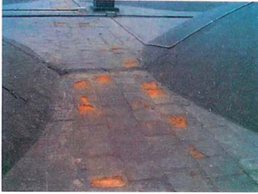
Foto A.13. Vista exterior - techo plano de la catedral por sobre encima de los pilares de madera cubierto con torta de barro y ladrillo pastelero.
