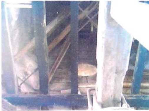
Foto A.48. Vista interior de estructuras de madera en la parte alta de las torres..
