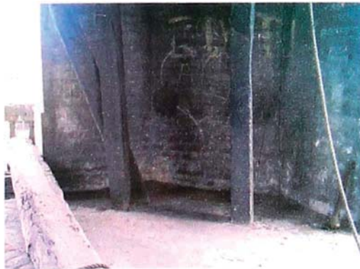
Foto A.46 Estructuras de madera de soporte de campanas de bronce al interior de las torres de la catedral.
