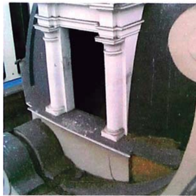
Foto 5.37. Agrietamiento en zona inferior de la cúpula.
