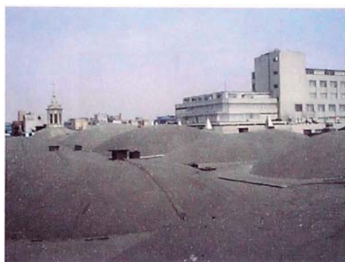
Foto A.29. Vista exterior de las bóvedas nervadas en la que se muestra como éstas atraviesan el nivel del techo plano de madera. Obsérvese cobertura exterior hecha con torta de barro, ladrillo pastelero y mortero de cemento.
