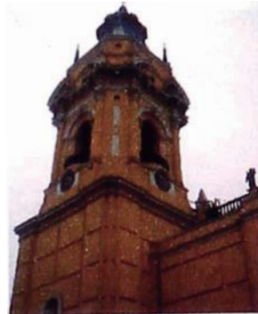
Foto A.42 Vista del lateral de la torres de la catedral.
