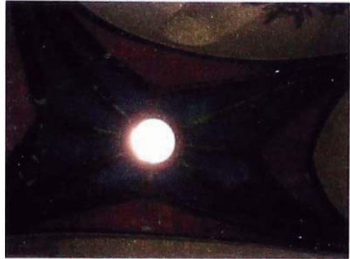
Foto A.39. Vista interior de bóvedas de capillas del lado de la puerta de los Naranjos.
