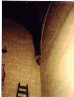
Foto A.50. Vista interior dentro de capilla de muro estribo o contrafuerte ubicado hacia la izquierda.
