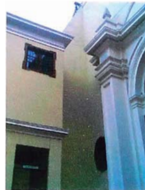
Foto A.55. Vista desde el patio hacia la puerta de los Naranjos de muro estribo en eje 6.
