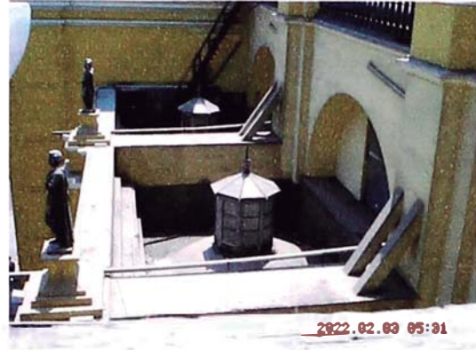
Foto 5.17. Bóvedas sobre capilla del lado de la Puerta de los Judíos. Los contrafuertes llegan a 2m por sobre encima de las bóvedas.
