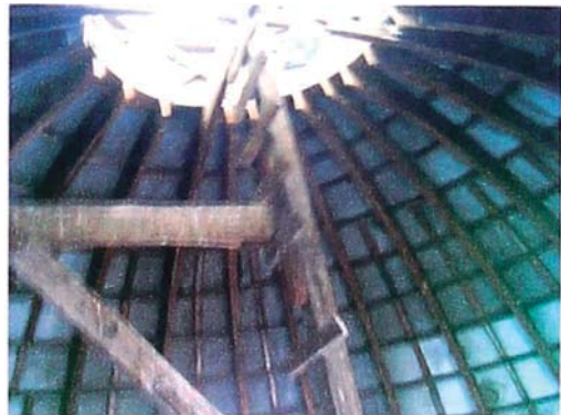
Foto A.59. Vista interior de la cúpula posterior de la catedral. Se observa estructura de madera con cobertura exterior.
