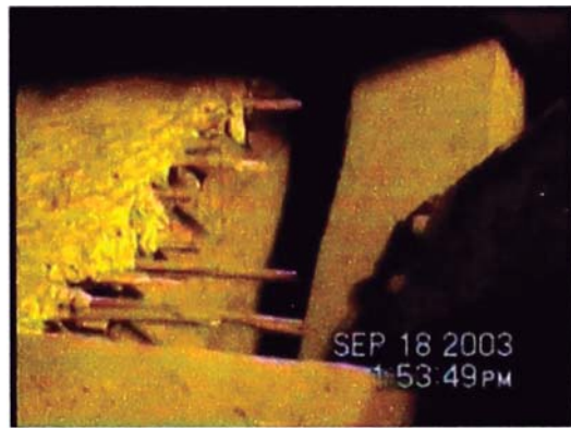
Foto 5.21. Buen estado de conservación de la torta de barro colocada sobre la cobertura de madera de las bóvedas.
