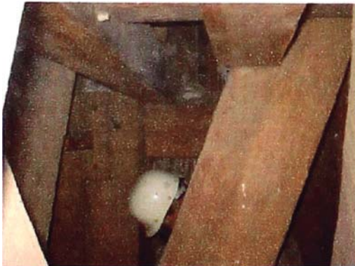
Foto 5.4. Madera al interior del pilar de madera, en buen estado de conservación.
