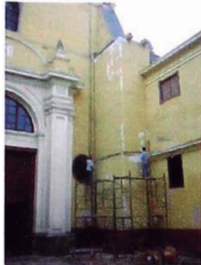
Foto A.54. Vista desde el patio hacia la puerta de los Naranjos de muro estribo en eje 5.
