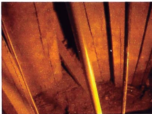
Foto 5.20. Buen estado de la madera de nervaduras en la zona de apoyo sobre los pilares.
