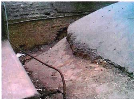
Foto 5.14. Capa de mortero de cemento colocada sobre bóvedas de capillas laterales de ladrillo y cal.
