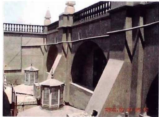
Foto A.61. Vista exterior de zona de arbotantes eliminados del lado de la puerta de los Naranjos y hacia las torres de la catedral.
