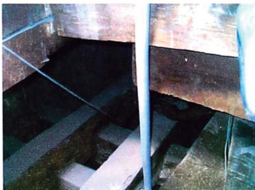
Foto 5.28. Dos elementos conectores en cada dirección, uniendo soportes verticales y diagonales, entre ejes 4 y B.
