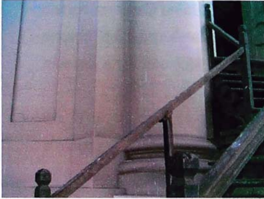
Foto 5.40. Fisura en pared de la torre ubicada del lado de la Puerta de los Judíos.
