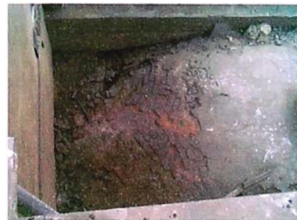
Foto 5.15. Pérdida de unidades de ladrillo en bóvedas laterales ubicadas del lado de la puerta de San Cristóbal.
