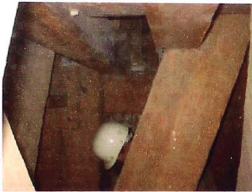
Foto A.9. Vista interior – Diagonales de madera que unen las columnas de madera ubicados al interior del pilar.
