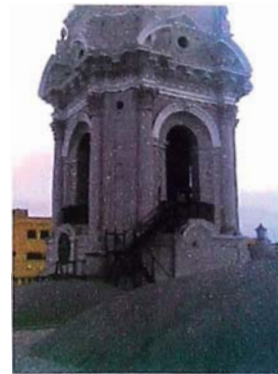
Foto A.43. Vista del segundo cuerpo de la catedral. Obsérvese escalera de acceso a los campanarios.
