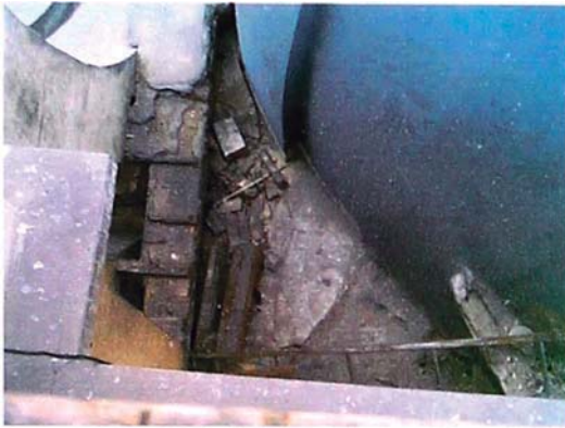
Foto 5.36. Deterioro en la base de la cúpula posterior de madera y quincha.
