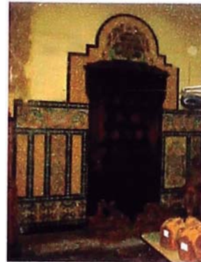
Foto A.51. Muro estribo. Obsérvese puerta de armario creado dentro de muro.
