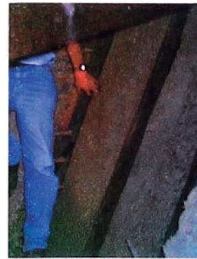
Foto A.16. Vista interior – Diagonales de madera que soportan las vigas principales del techo.
