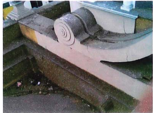
foto A.65. Vista exterior de zona de arbotantes eliminados del lado postrero de la catedral. Nótese elementos decorativos de madera con cobertura exterior de madera y yeso.
