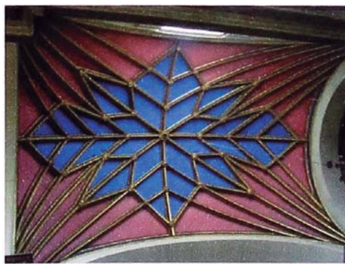
Foto A.31. Vista interior de bóvedas nervadas que muestra el estilo neo-gótico en forma de cruces de Malta.
