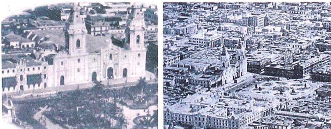
Fotos 4.2 y 4.3. Vistas aéreas de la Plaza Mayor de Lima. Nótese existencia de arbotantes sobre los muros estribos de la catedral.
