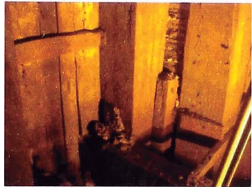
Foto A.10. Vista interior – Columnas de Pilar. Obsérvese tablonces de madera a modo de cerramiento para la cobertura del Pilar.
