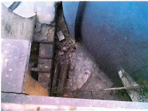
Foto A.58 Zona de Apoyo de la cúpula posterior de la catedral desplantada sobre bóveda nervada ubicada entre las puertas de Santa Apolónia y San Cristóbal.
