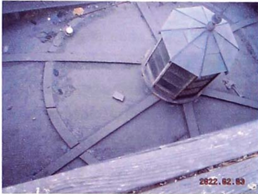
Foto 5.16. Bóveda sobre capilla del lado de la Puerta de los Judíos.
