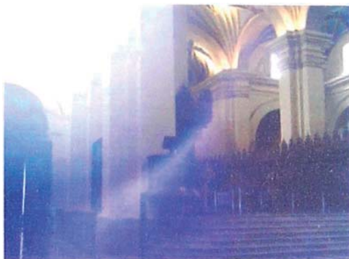
Foto A.5. Vistas panorámicas de los pilares de madera al interior de la catedral.
