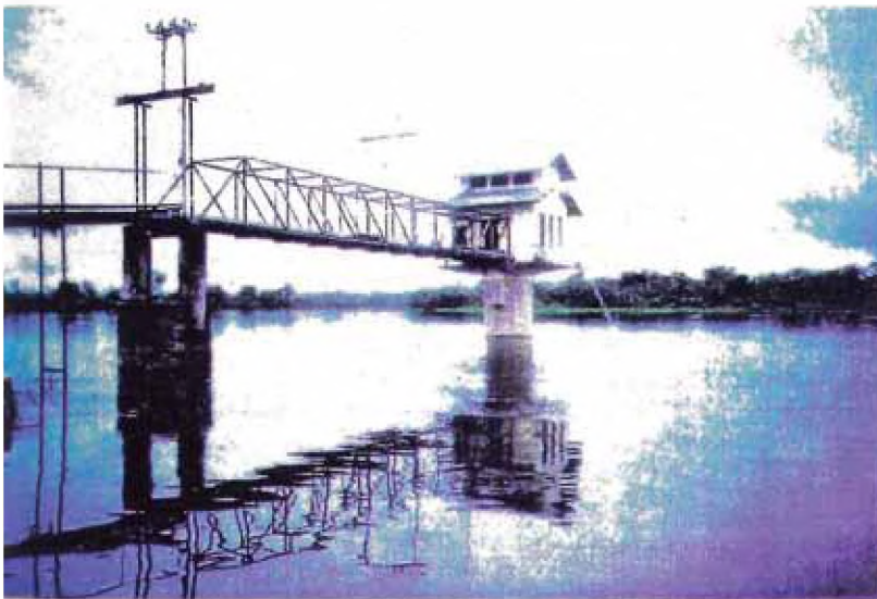
FOTO 2.1 - 2 Captación N°1 (antigua) y línea de impulsión \varnothing 16'' sobre el río Nanay
