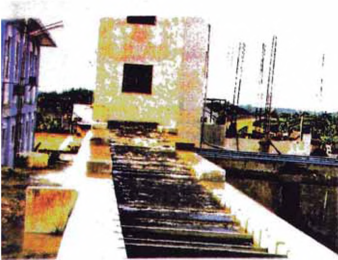
FOTO 2.3 - 2 Planta N°1 (antigua), floculador sobrecargado
