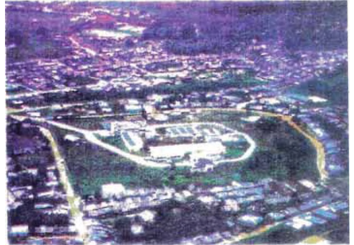
FOTO 2.3 - 1 Planta de Tratamiento (Pampachica), vista panorámica
