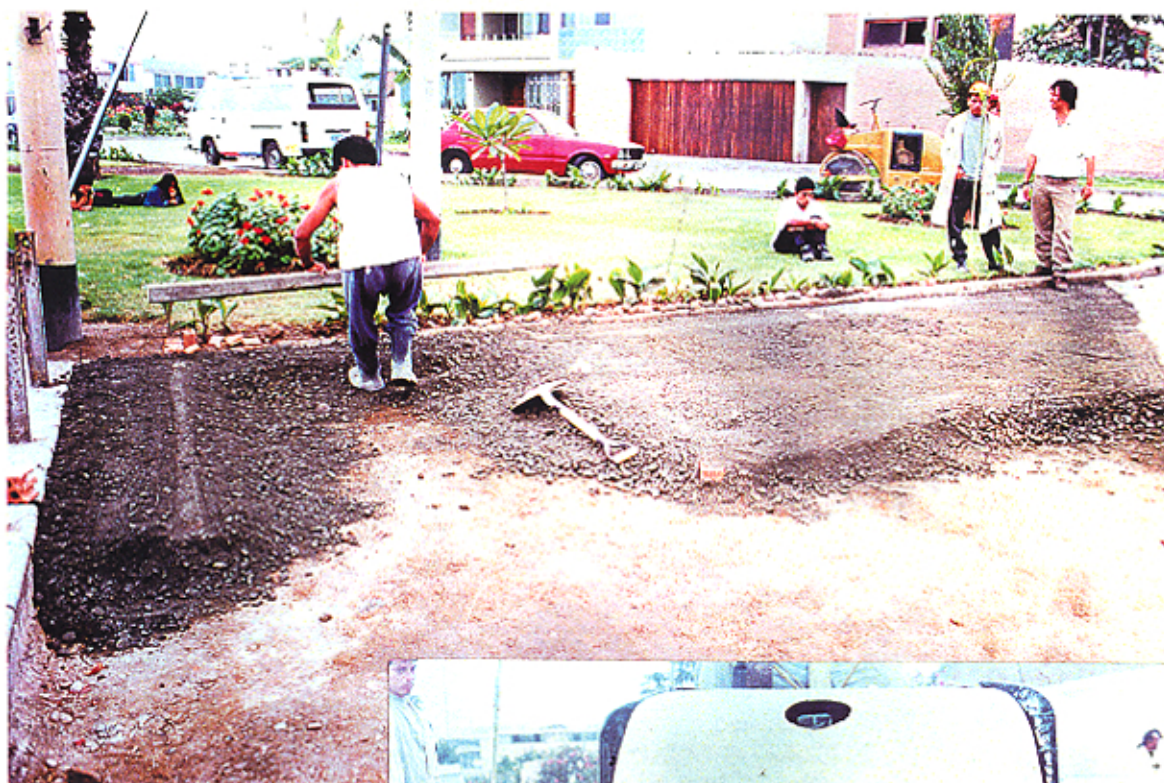
Foto 12 : Distribución del Concreto.
