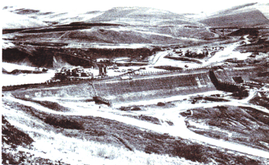
CONSTRUCCIÓN DE PRESA DE CCR (WILLOW CREEK)
