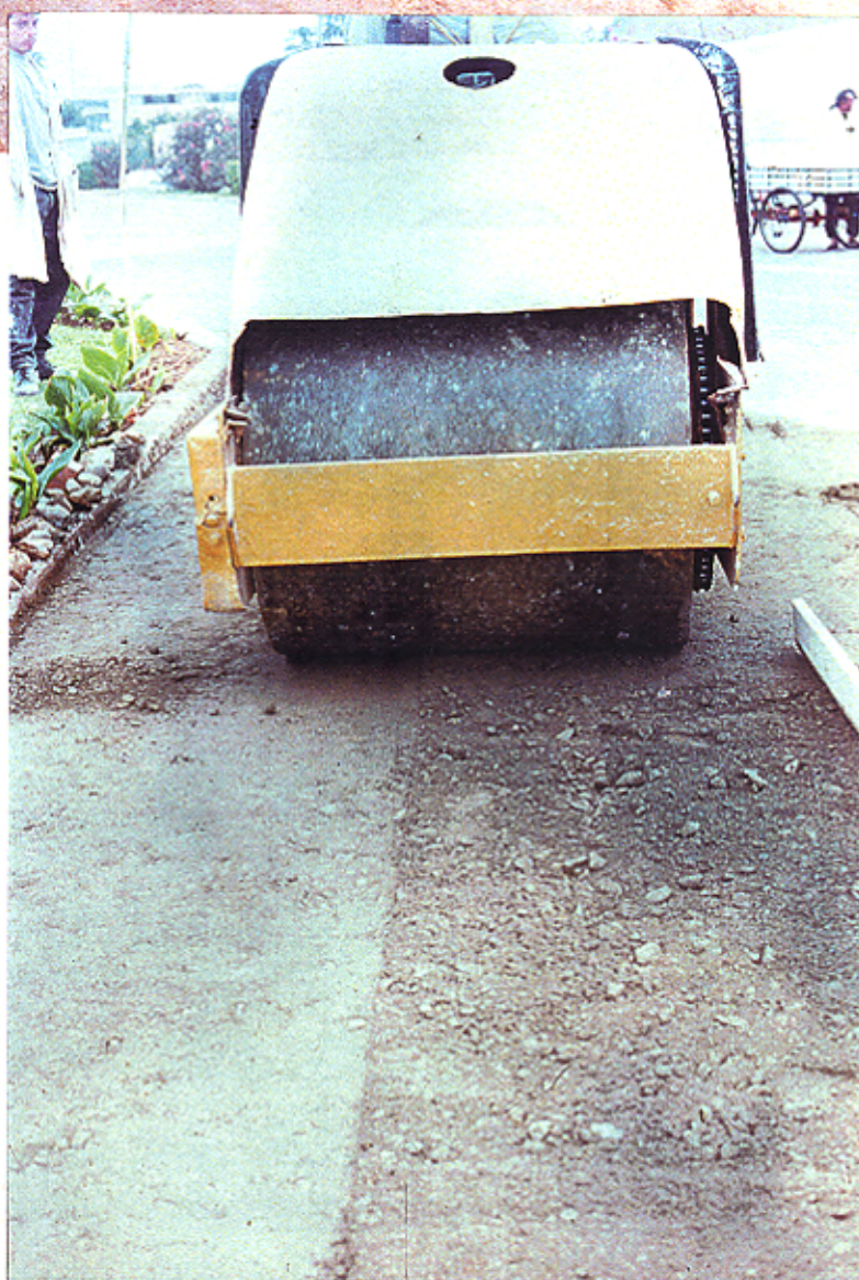
Foto. 13 : Compactación de losa de concreto.
