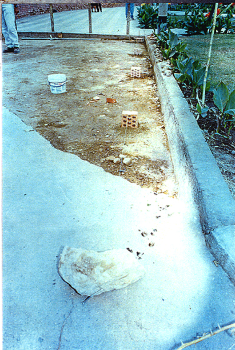
Foto 7 : Colocación de Niveles.
