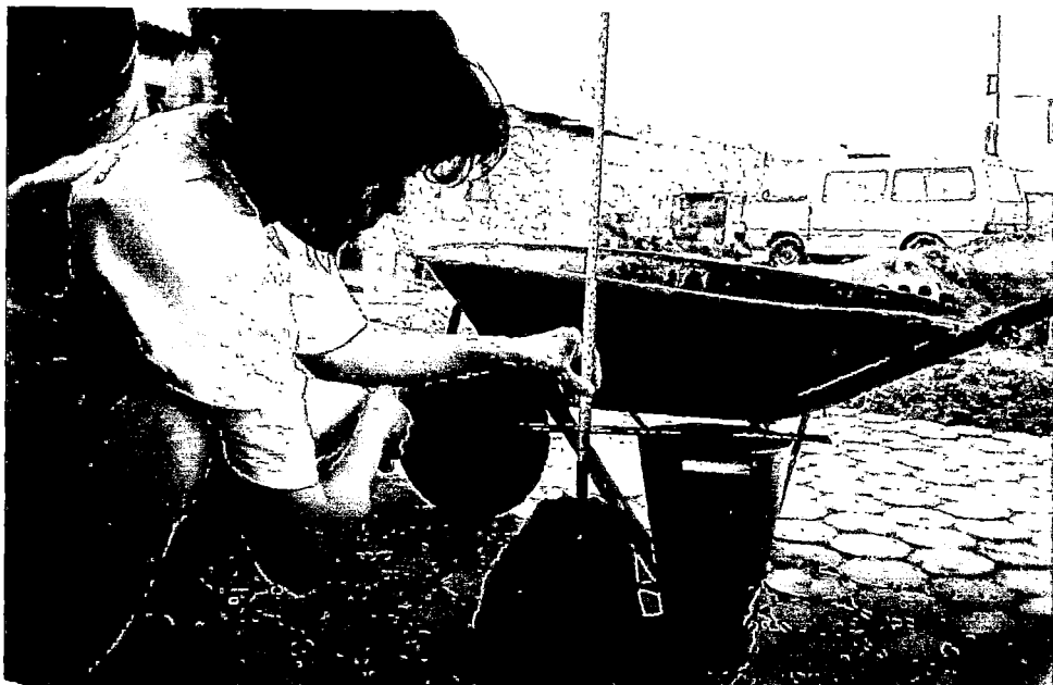
MEDICION DEL ASENTAMIENTO
