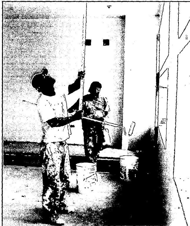
Trabajadores pintando sin usar EPP Peligros: Contacto con sustancias nocivas, inhalación de sustancias nocivas.
