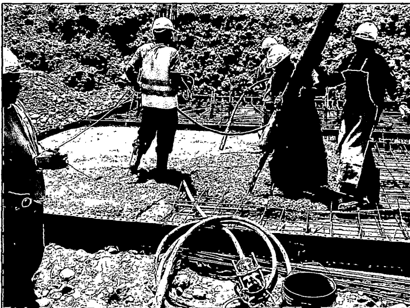
Trabajadores en vaciados de losa usando EPP completo: botas de jebe, guantes de cuero, casco, lentes, y además mandil.
