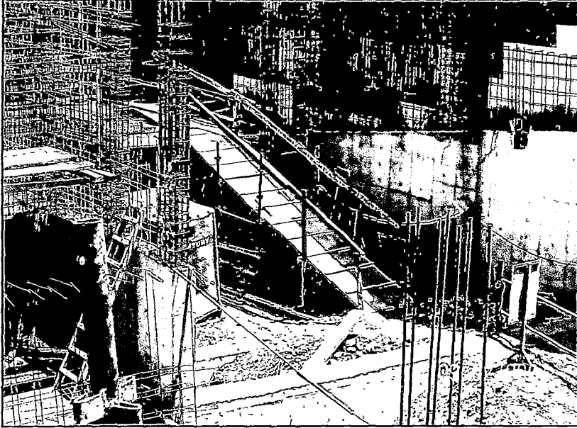
Rampa de ancho mínimo (0.90m), con baranda y soportes adecuados
