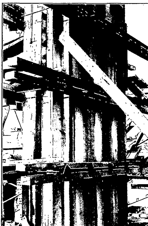
Foto 3.9 Encofrado usando pernos de sujeción.
