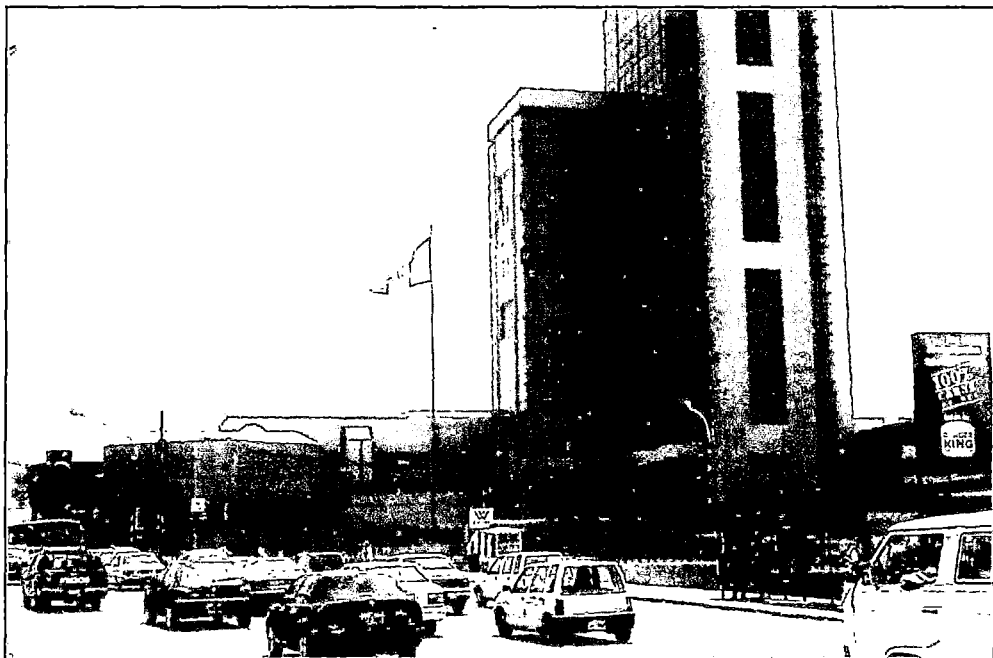
Foto N° 1.23 Edificio del ex-local de PETROPERU.
