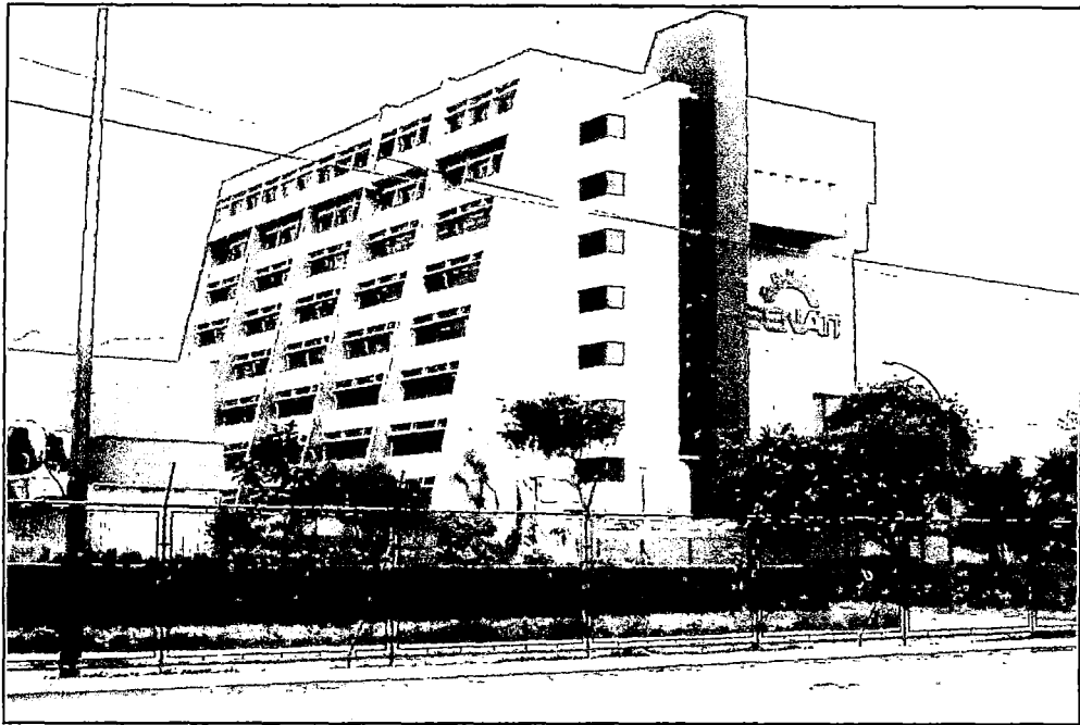
Foto N° 1.22 Local central de SENATI.
