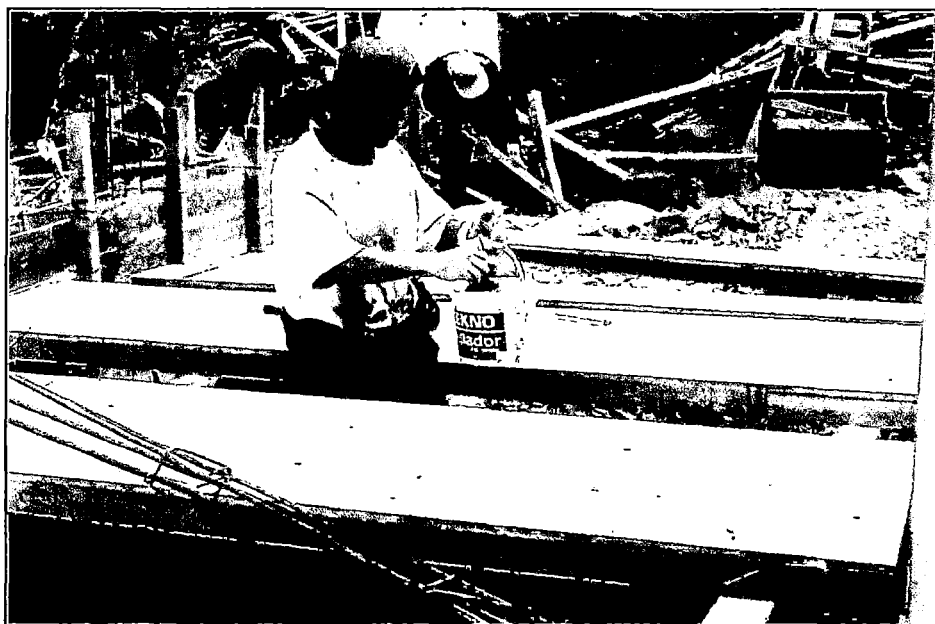
Foto 3.2 Aplicación con brocha del desmoldante en los paneles ya masilladas.
