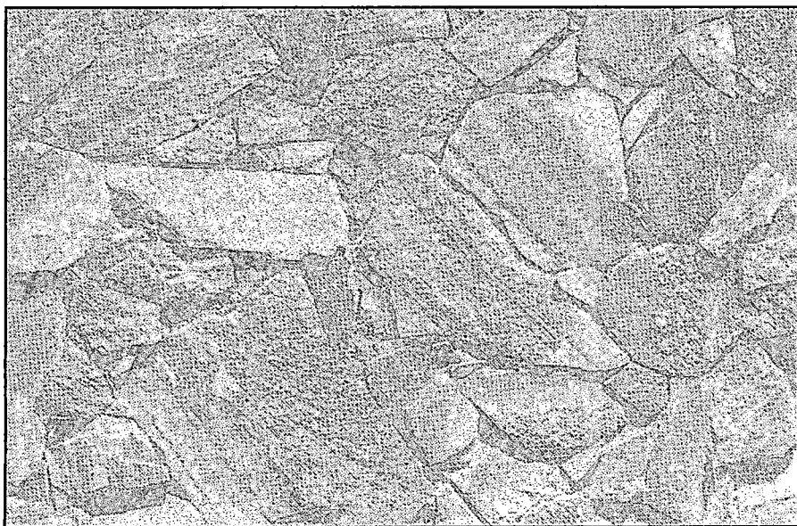
Foto N° 1.36 Acabado obtenido por traspaso del agregado.
