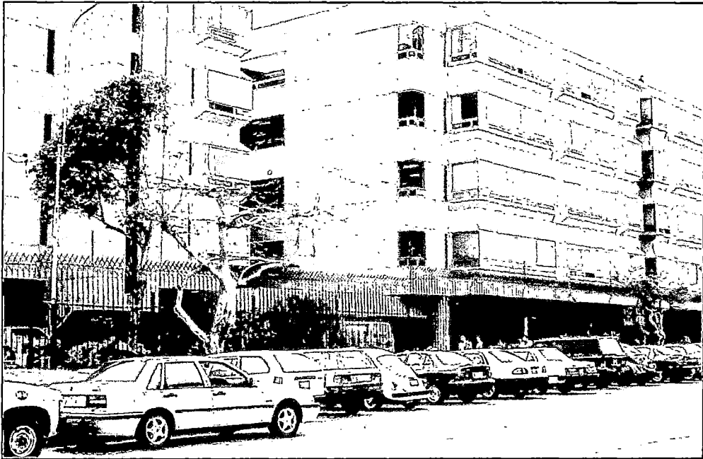
Foto N° 1.24 Sede principal de la Southern Perú, en Chacarilla del Estanque.
