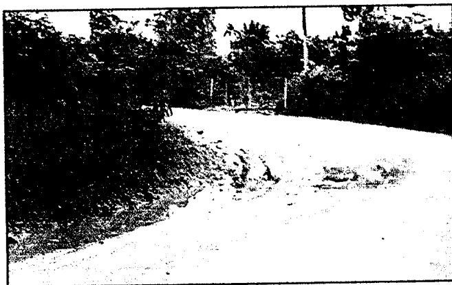
Figura 2.15. Drenaje Inadecuado (iii)
