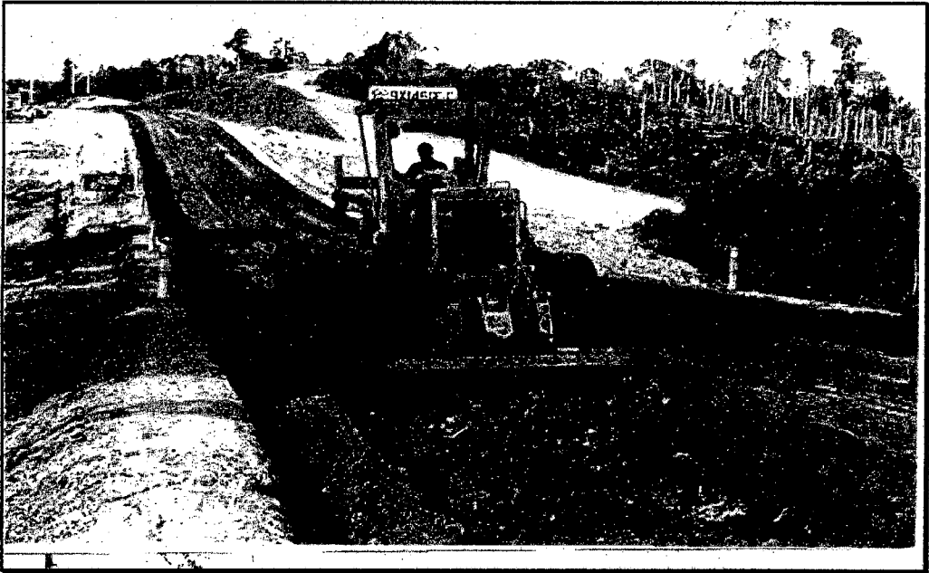
En la Figura 5.01 se muestra a la motoniveladora pasando rastra para romper el estrato.
