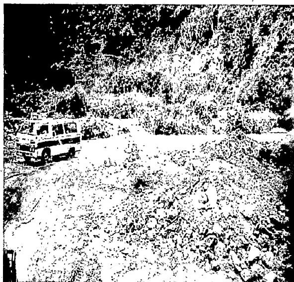
Foto 5: En la mayor parte de su longitud existía materiales acumulados (usualmente piedras) de la construcción inicial u otras actividades subsiguientes de rehabilitación y mantenimiento.
