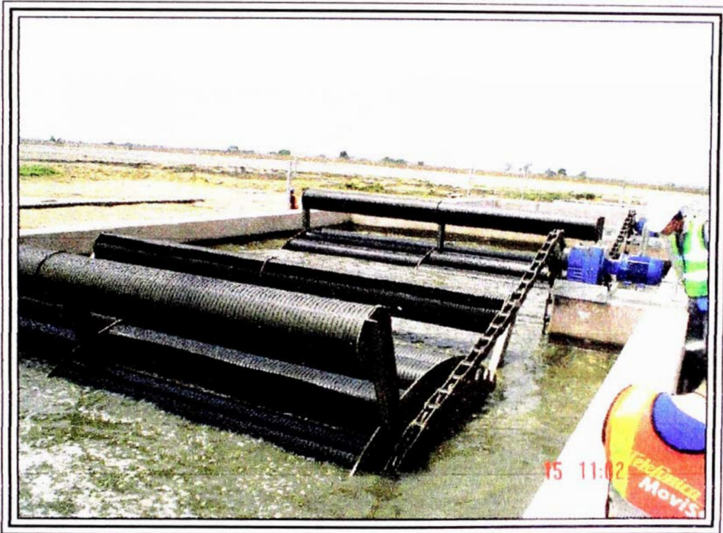
Foto 01 Reactor Biológico con Biodiscos-Aeropuerto Jorge Chavez
