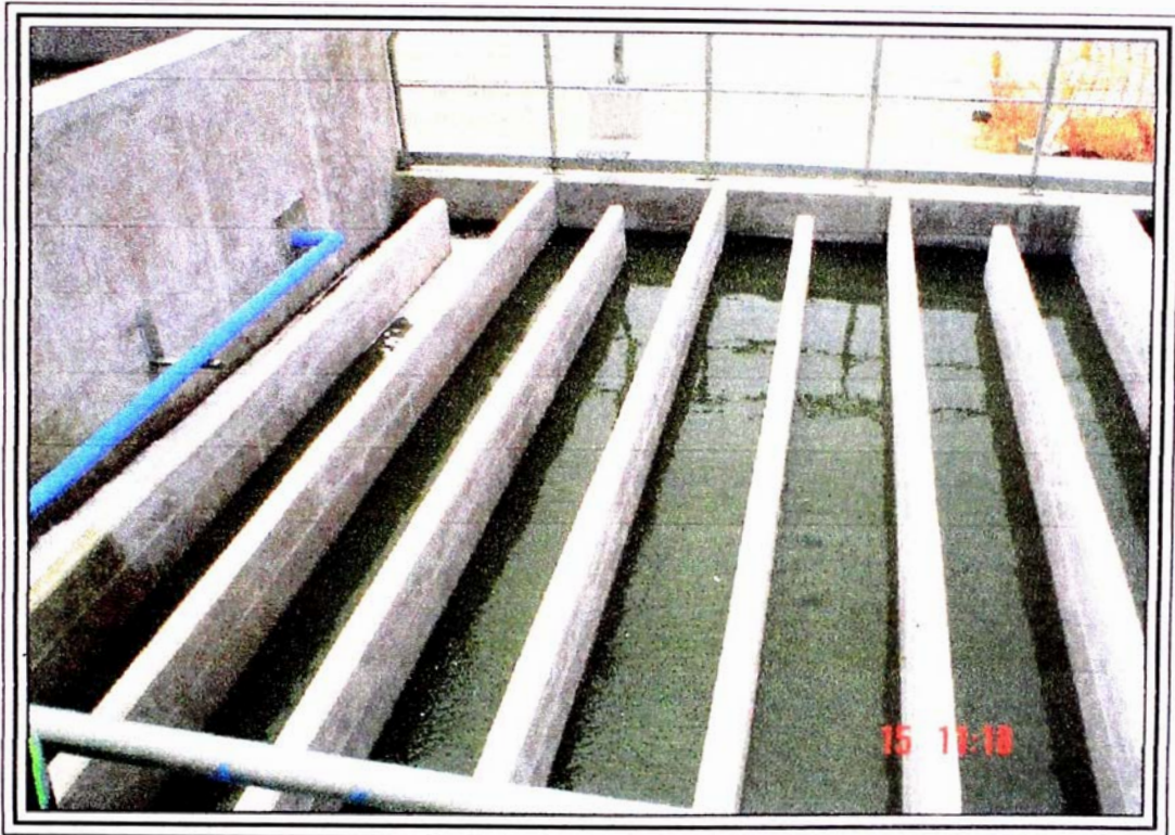
Foto 03 Cámara de contacto, aplicación de cloro-Aeropuerto Jorge Chavez
