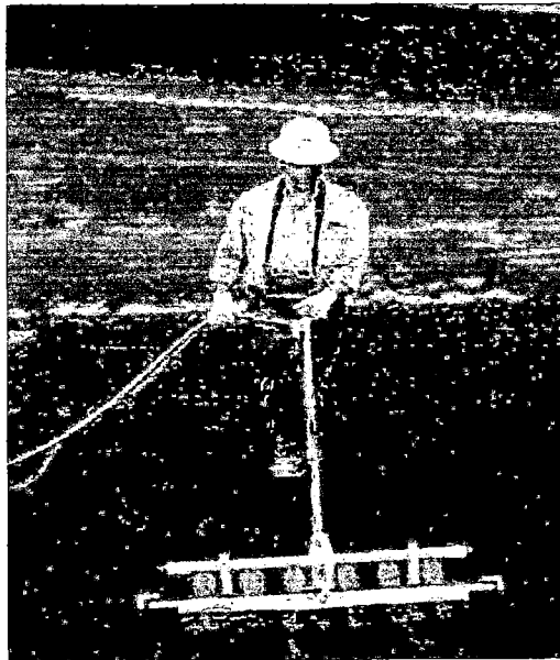
Figura 3.4 Ejecución del Método sobre la Geomembrana Expuesta
