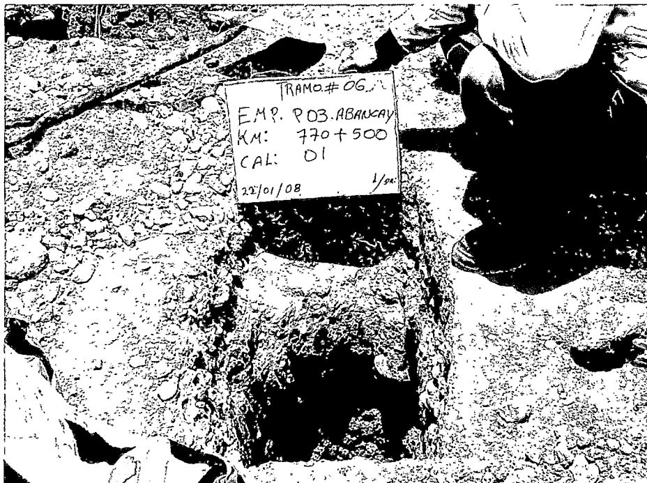
Foto 4: Calicata realizada en la plataforma del pavimento del sector R03S - Abancay
