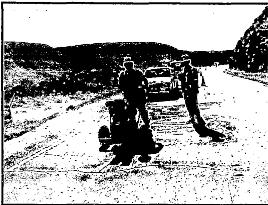
Foto 5.01: Una vez demarcado la fisura a tratar, se hace el ruteo de ser el caso.
