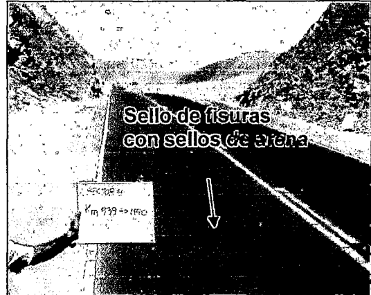
Fotos AN-27 y AN-28 Tratamiento de fisuras en ambos carriles
