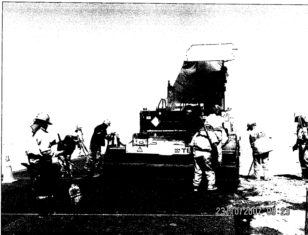
Fotos 5.45: Colocación de la Carpeta Asfáltica modificada de 5cm de espesor.
