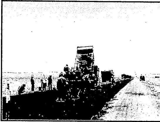
Foto 5.58: una vez solucionado el impase se procede a colocar la carpeta de e=5\text{cm} .
