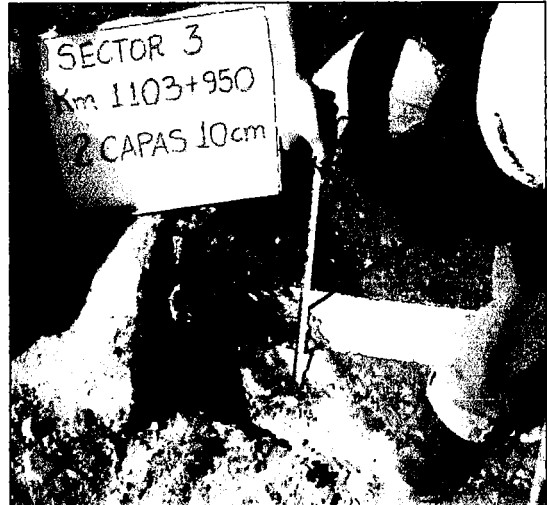
Fotos AN-21 y AN-22 La presencia de dos capas del pavimento, cada una de 10 cm
