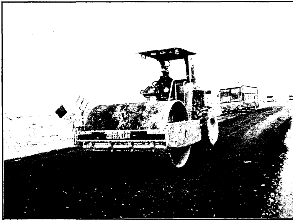
Fotos 5.42: Compactación de la Base Granular de 15.00 cm de espesor.
