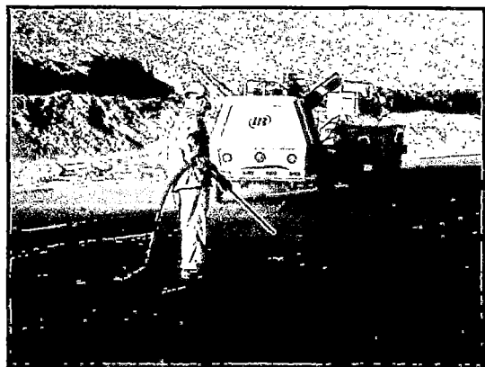
Foto 5.02: Antes de colocar el sellante elastomérico se hará la limpieza respectiva.
