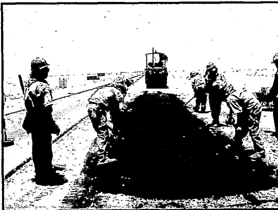
Foto 5.56: previa a la compactación, los rastrilleros acomodan el material asfáltico.
