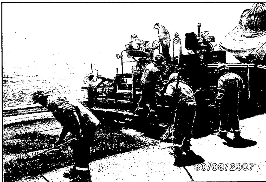
Foto 5.28: Tren de pavimentación
