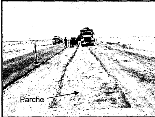
Foto 5.52: se ha realizado el corte y extracción del material acolchonado.
