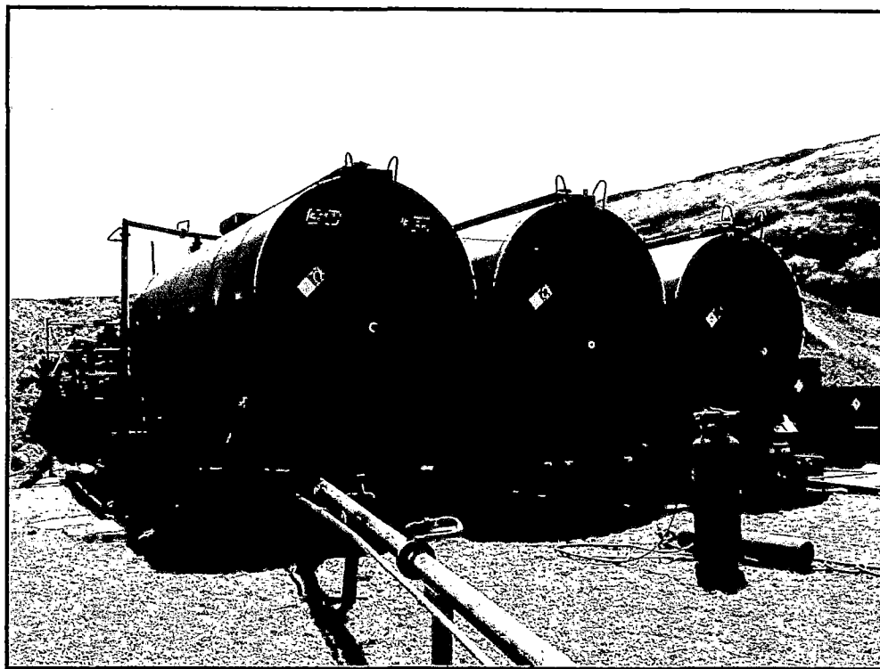
Foto 5.24: Tanques de Almacenamiento del CAMP en Obra
