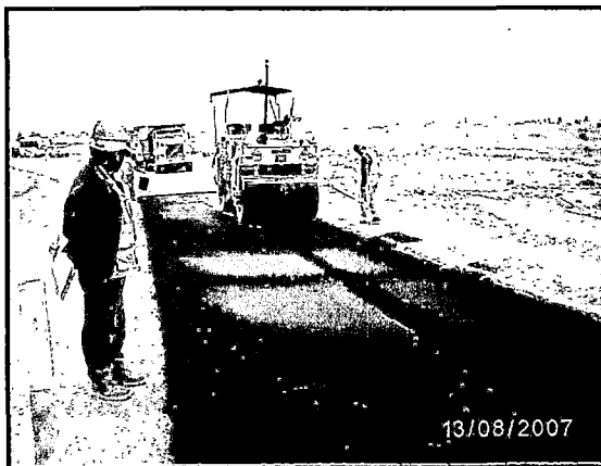
Foto 5.21: compactado de la mezcla asfáltica.
