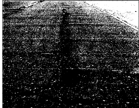
Foto AN-23 y AN-24 Presencia de fisuras fuera del área corrugada, con aberturas mayores a 3 cm
