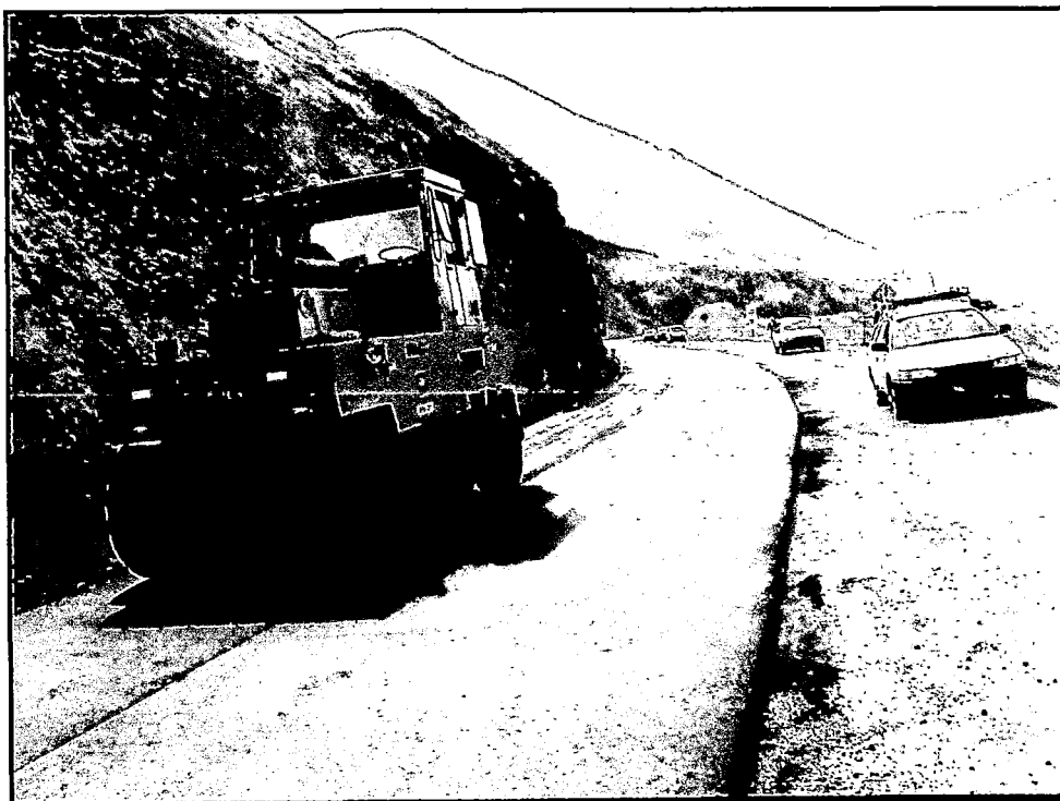
Foto 5.33: Compactación con rodillo liso
