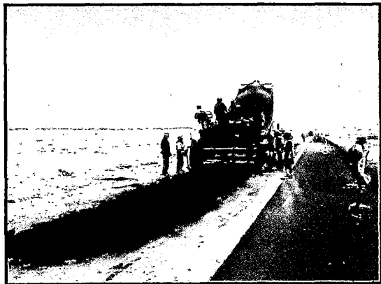
Foto 5.55: Con la esparcidora del pavimento se logra distribuir la mezcla en forma uniforme.
