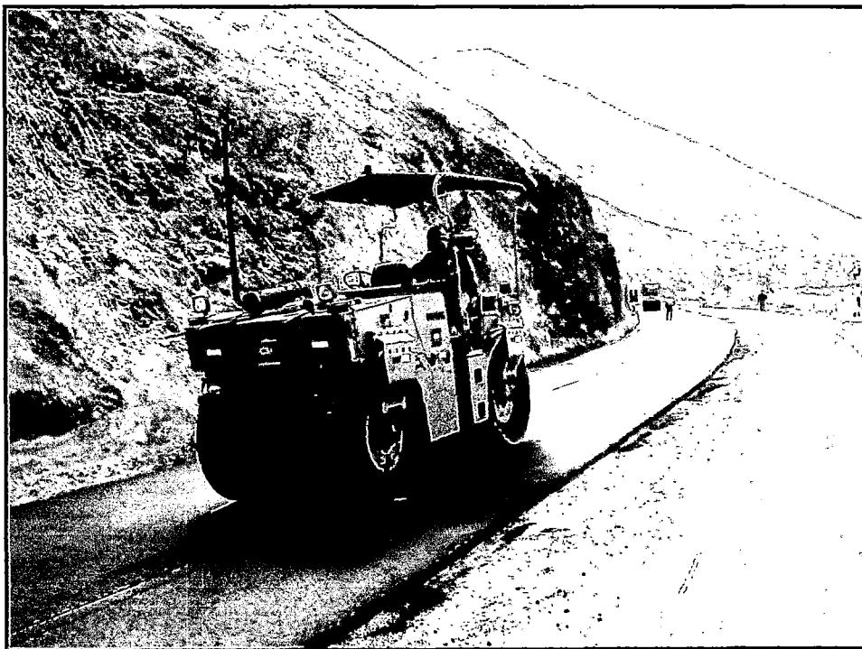
Foto 5.32: Compactación con rodillo de Neumáticos
