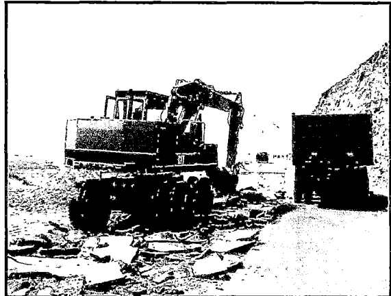
Foto 5.14: eliminación del material de corte a botaderos establecidos.
