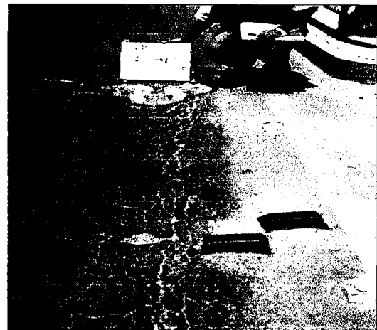
Fotos AN-11 y AN-12 Sector del peaje donde deberá levantarse todo el pavimento existente
