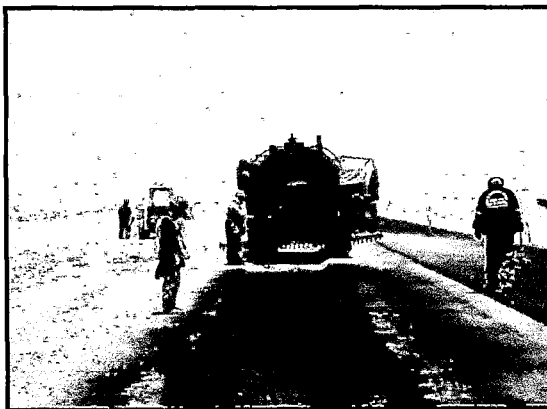
Foto 5.52: se ha realizado el corte y extracción del material acolchonado.
