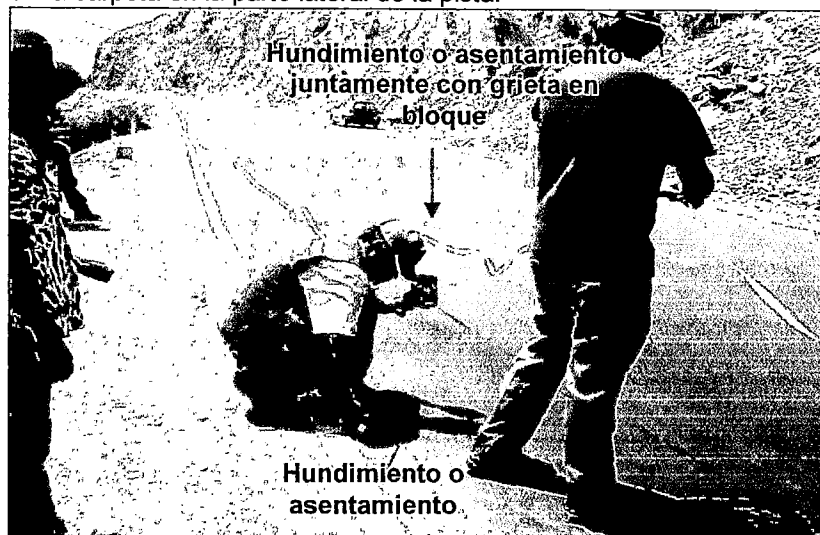
Foto AN3-1 Hueco en la parte lateral de la pista juntamente con un asentamiento medio, pudiendo tener su origen por el asentamiento del talud o mal funcionamiento de la base y envejecimiento completo de la carpeta en la parte lateral de la pista.
