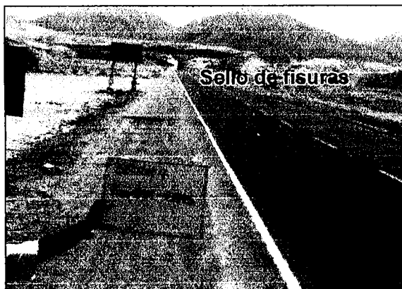
Fotos AN-25 y AN-26 Carpeta con sellos desgastados y sellos de fisuras
