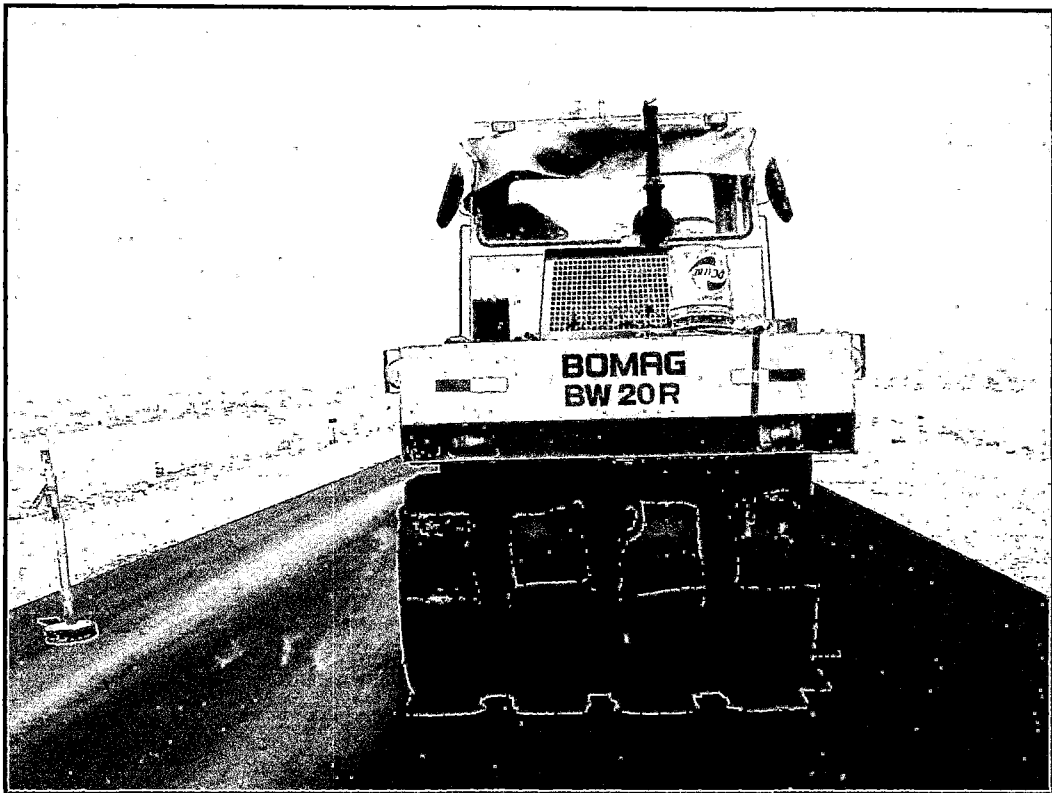
Fotos 5.47: Compactación de la Carpeta Asfáltica modificada de 5cm de espesor, con rodillo de neumáticos.
