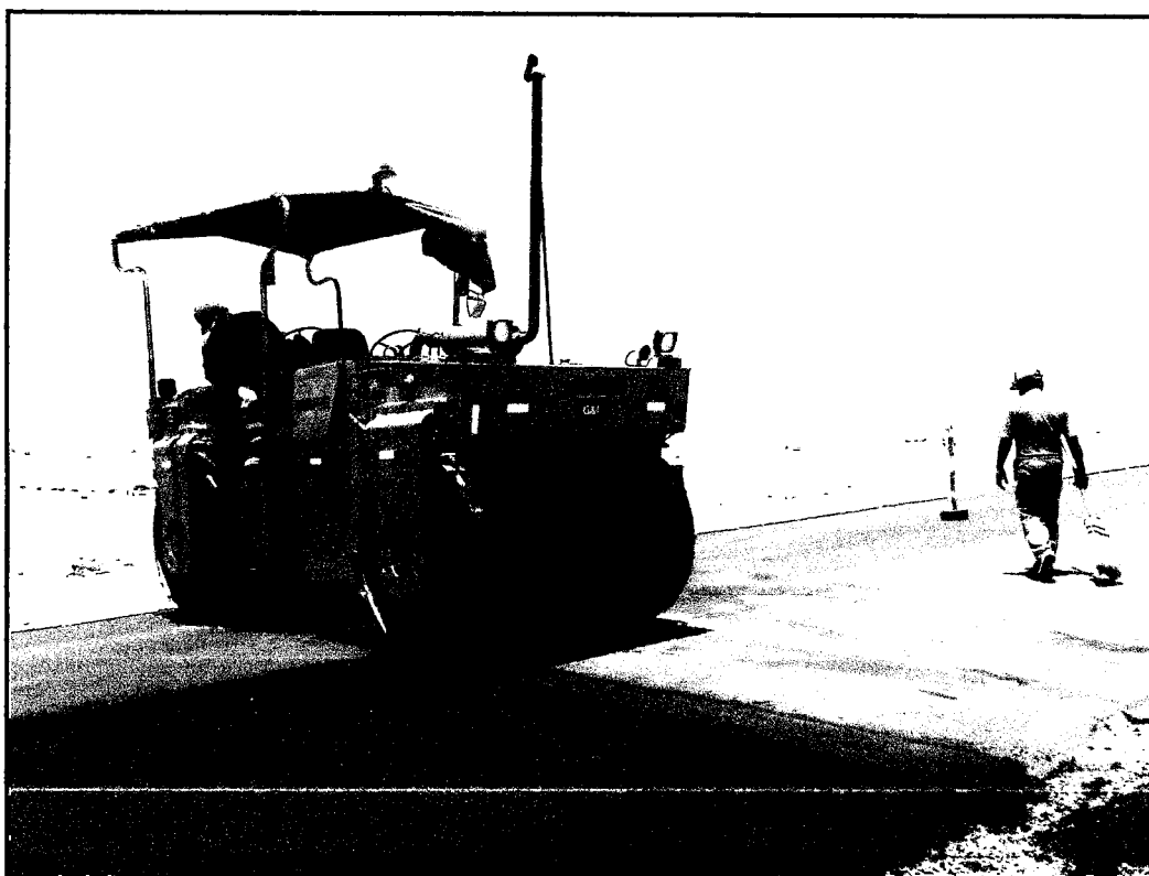
Fotos 5.46: Compactación de la Carpeta Asfáltica modificada de 5cm de espesor con rodillo liso vibratorio.
