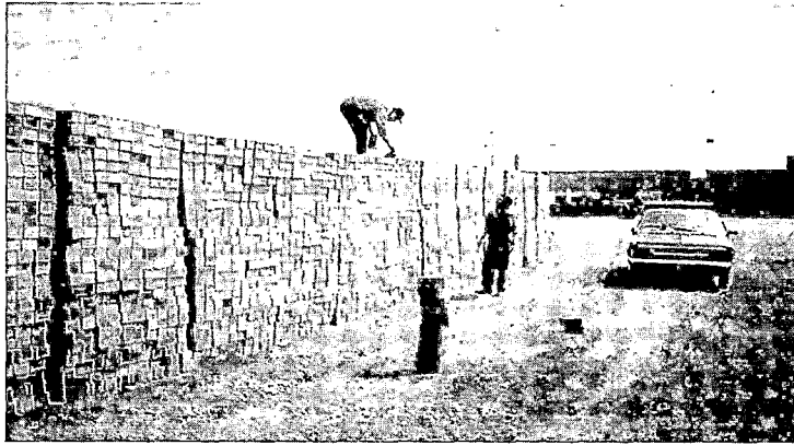
FOTO N° 29: LOTE Y MUESTREO EN PLANTA
