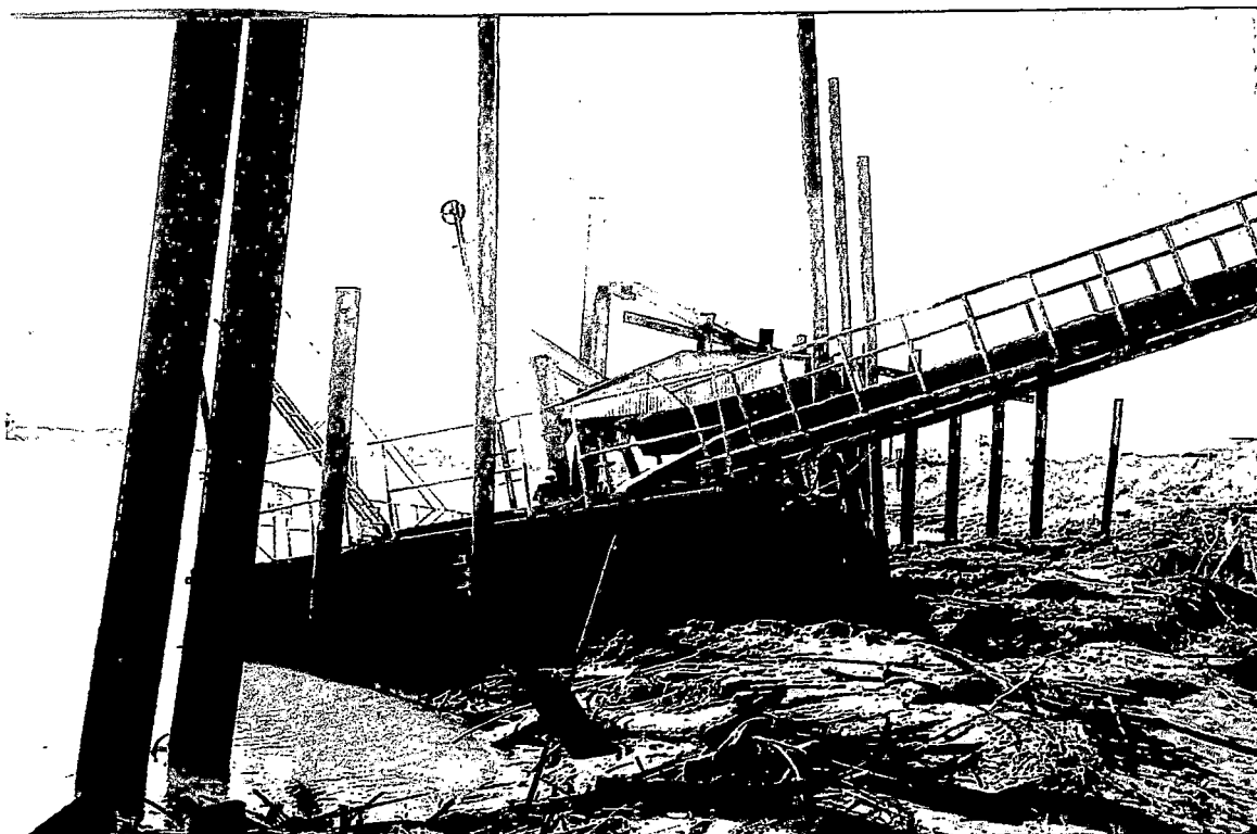
Pontón N° 01: Vaciante, se observa una inclinación del Pontón, la motobomba no puede.
