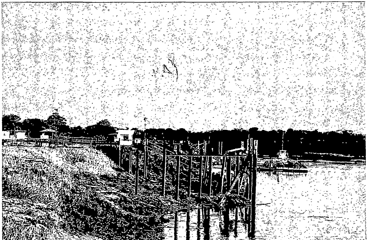
Pontón N° 01: La existencia de estos pilotes efectua un trabajo de retención de arena y palizada.
