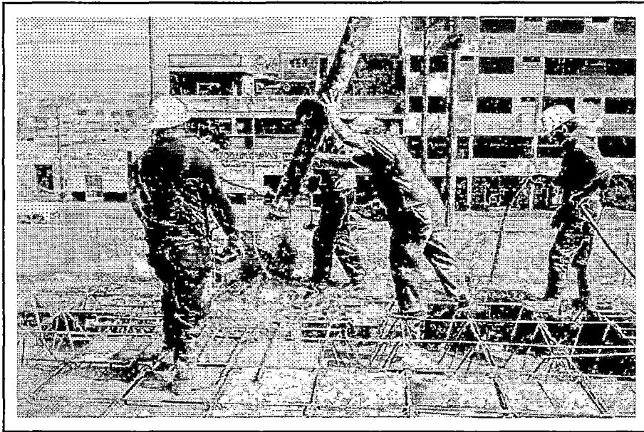
Fotografía N°4-16. Proceso de vaciado de concreto
