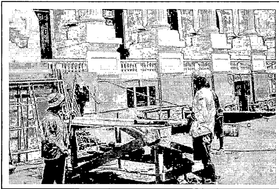
Fotografía N°6-2 Habilitación de los diagonales de la tridilosa
